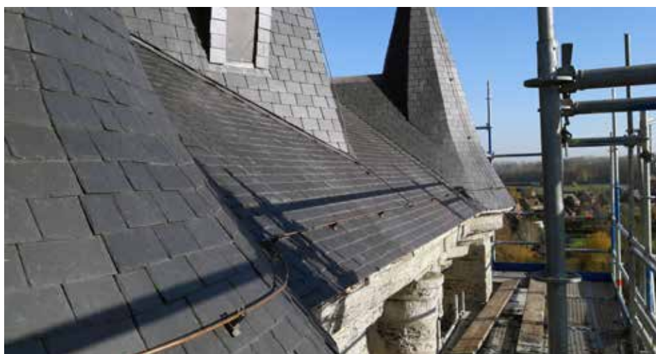
En coordination avec le couvreur, fixation des conducteurs en cuivre à l'aide de pattes en cuivre fixées directement sur le voligeage. Les câbles épousent la forme des couvertures © SPW/AWaP
