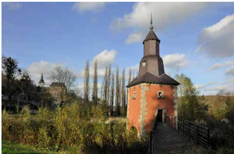
Colombier de l'abbaye de Floreffe. Photo G. Focant © SPW/AWaP
