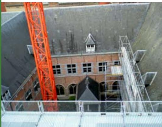
Vue du cloître : montage de l'échafaudage de l'aile Est. La façade de l'aile Nord a été restaurée lors d'une phase antérieure.
