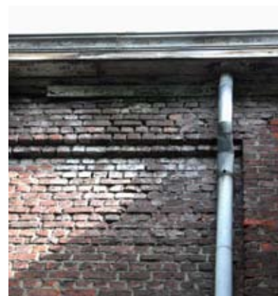
Foyer populaire à Court-Saint-Etienne – FOS pour les corniches et descentes d'eau. Photo D. Preud'homme © SPW
