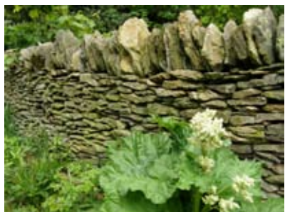
Mur à crête à cayaux de Blaton (Bernissart) © QVW
