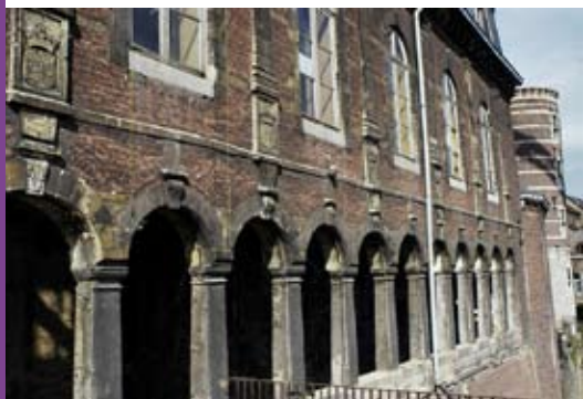
Façade méridionale de l'Hôtel des Comtes de Méan © Caroline Bolle, SPW-DGO4-DLg1 - Service de l'Archéologie de Liège.
