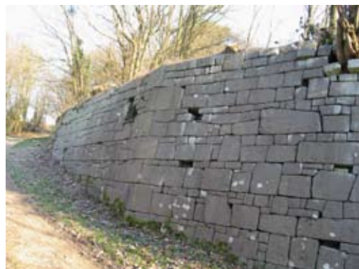
Mur à appareil cyclopéen à Chokier (Flémalle) © QVW
