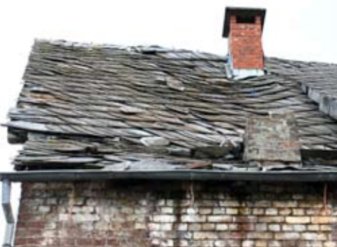
Stavelot – FOS pour réparation de la toiture d'une maison rue Haute. Photo D. Preud'homme © SPW
