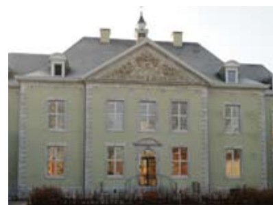
Le château Nagelmackers après achèvement des travaux. Photo Guy Focant © SPW
