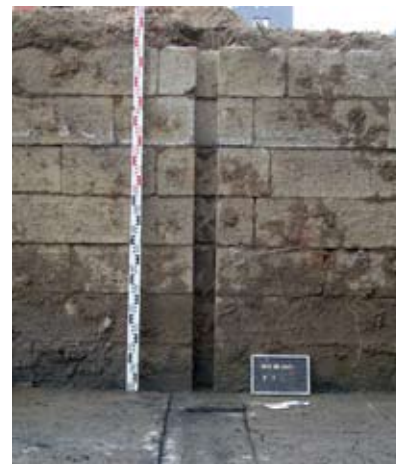
L'une des deux coulisses accueillant un vantail du système d'écluse. © SPW/DGO4
