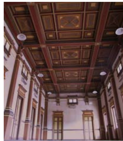
Plafond à caissons de la Salle du Conseil après restauration. © Enrique Ruiz de Villa.
