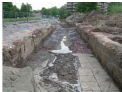
Vue générale des vestiges de la Trouille canalisée, vers l'amont. © SPW/DGO4
