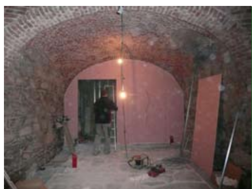
Chantier en cours du sanitaire dame. © IPW
