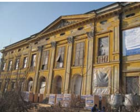
Hongrie - Château Károlyi, façade arrière en cours de restauration
