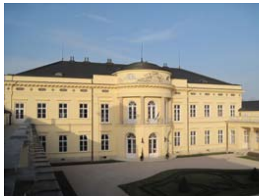
Hongrie - Château Károlyi, façade avant restaurée
