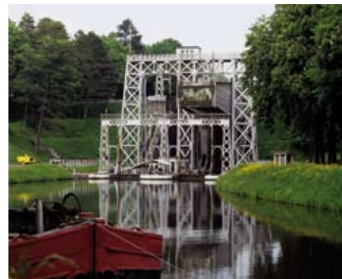
Un des ascenseurs du canal du Centre. Photo G. Focant © SPW
