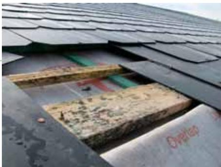
Suite à une mauvaise exécution de la couverture ET à une mauvaise mise en œuvre de l'écran de sous-toiture, les infiltrations d'eau ne sont pas évacuées correctement (voir la cuvette avant l'égout), l'eau stagne en pied de toiture, s'évapore dès que la température le permet et crée un « brouillard » propice au développement de pathologies telles que moisissures, champignons xylophages, etc. Il a fallu une seule saison, l'hiver, pour connaître la situation telle que montrée ! © SPW
