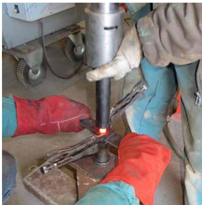
Fig. 2a. Une forge traditionnelle fut utilisée pour chauffer les rivets des assemblages rivetés en fer forgé. 2b. Un marteau pneumatique a permis d'installer les rivets en acier des assemblages rénovés © Q. Collette
