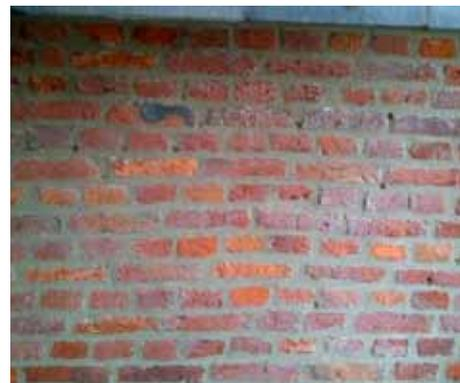
Suite à des essais de pénétration sur le mortier frais, de nombreuses cavités d'une profondeur supérieure à 10 mm ont révélé une mise en œuvre inadéquate, le mortier n'étant pas suffisamment « serré » © SPW
