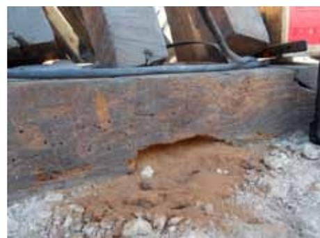
Trous d'envols sur une sablière et pulvérisation avancée de la face en contact avec la maçonnerie © SPW
