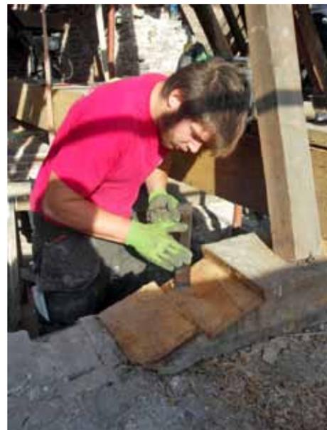
Bûchage d'une sablière jusqu'à disparition complète des trous d'envol des insectes xylophages et préparation du trait d'assemblage © SPW
