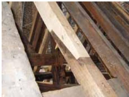
Remplacement d'une partie d'un chevron et assemblage du greffon, de nature et de section identiques, via un sifflet désaboté chevillé © SPW
