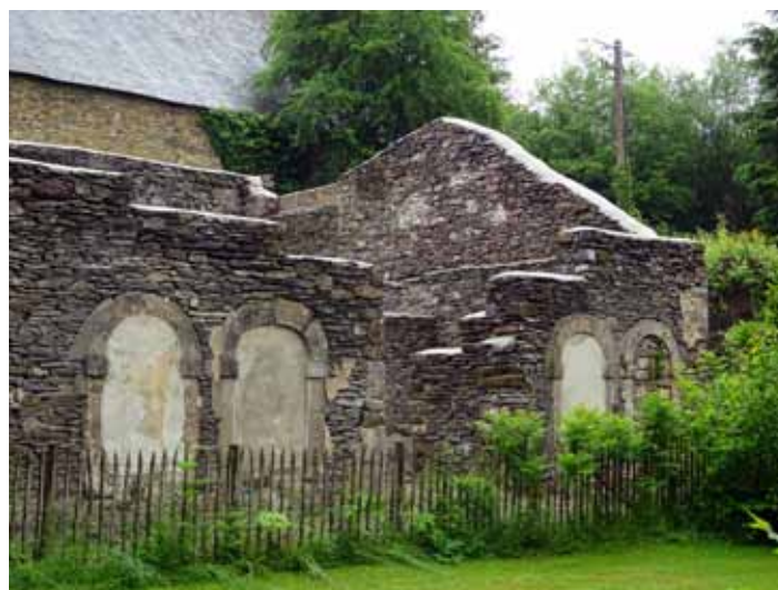
Le chantier de l'affinerie © IPW
