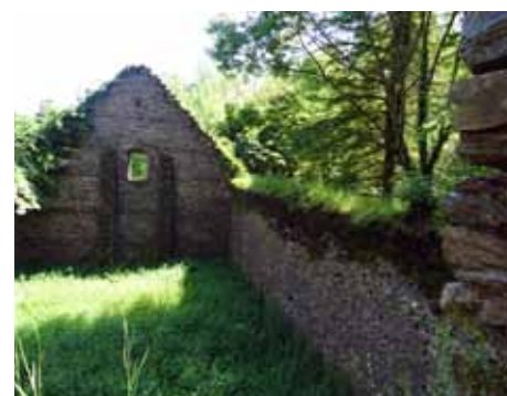
Le chantier de l'affinerie © IPW
