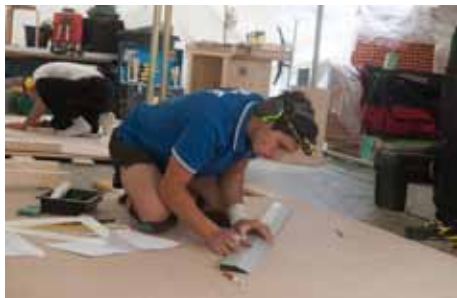
Photo G. Focant © SPW-Patrimoine
