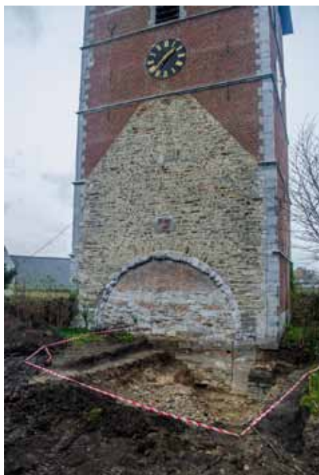
Localisation du sondage à l'angle nord-est du beffroi. Photo M. Siebrand © SPW / DGO4
