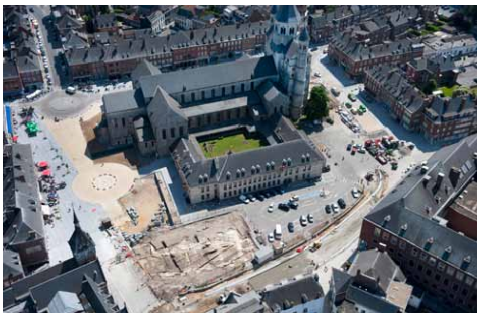
Le centre historique de Nivelles durant les travaux en 2010. Photo G. Focant © SPW / DGO4 / Département du Patrimoine
