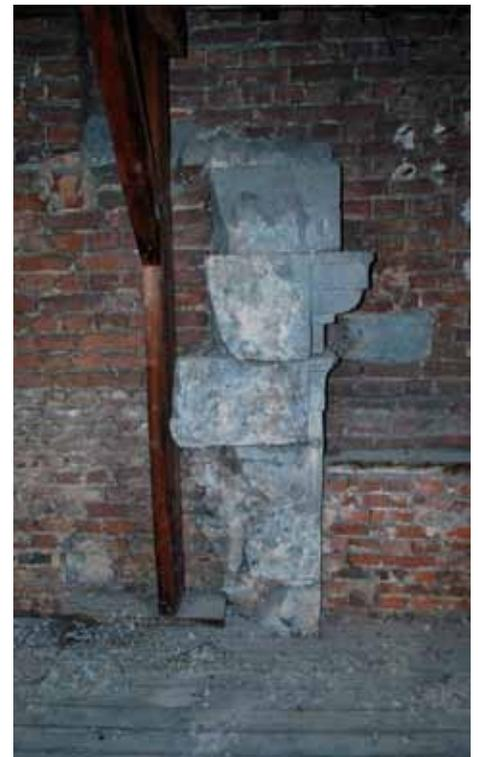
Fig. 6 : Pilastre engagé de la façade de l'église de 1700, imbriqué dans le bâti au niveau de l'ancien « Café du pont ». Photo M. Verbeek © SPW
