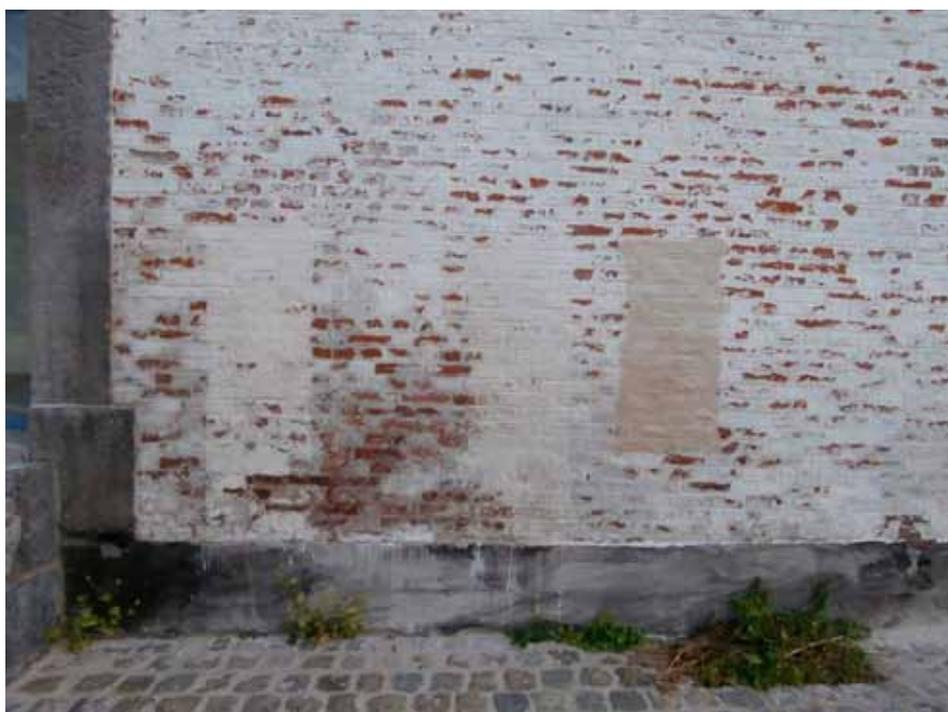
Cette photo illustre différents essais de traitement de surface des maçonneries fortement contaminées par des sels. Les produits utilisés sont les suivants : un badigeon à la chaux aérienne, une peinture aux silicates, un badigeon à la chaux hydraulique et un badigeon à la chaux hydraulique adjuvant. Aucun de ces produits n'a donné satisfaction. Après quelques mois seulement, chaque produit a commencé à disparaître, la durée de vie variant d'un produit à l'autre en fonction de sa nature © SPW
