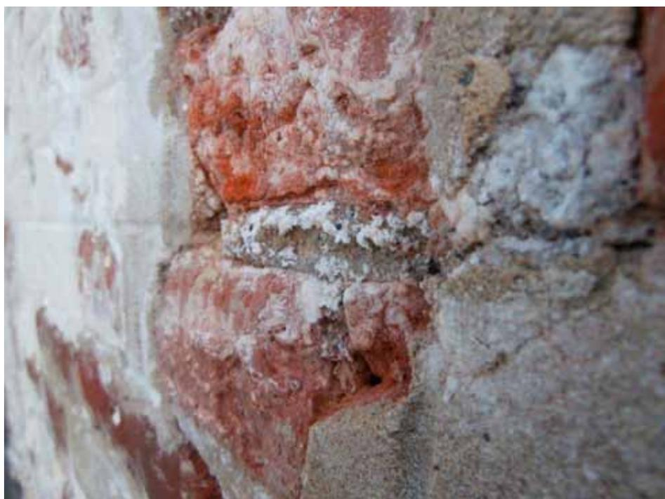
Au centre de la photo, apparition très marquée de sel liée au séchage de la maçonnerie. Lors de la cristallisation des sels, ceux-ci exercent une pression telle que le badigeon ou peinture s'écaille. Dans certains cas, des morceaux de briques et/ou mortier peuvent également éclater sous cette pression © SPW
