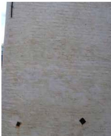
Taches jaunâtres typiques de la présence de sels (probablement des nitrates) dans la maçonnerie © SPW
