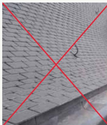
*Pied de coyau avec pente très faible ne permettant pas une pose à trois épaisseurs (double recouvrement). Même une pose en quatre épaisseurs (triple recouvrement) ne semble pas la plus appropriée © SPW*
