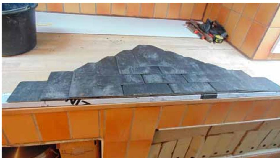
Détails de pose d'ardoises 30/20, en quatre épaisseurs, générant un triple recouvrement avec un pureau de 7,5 cm et un recouvrement de 15 cm © SPW
