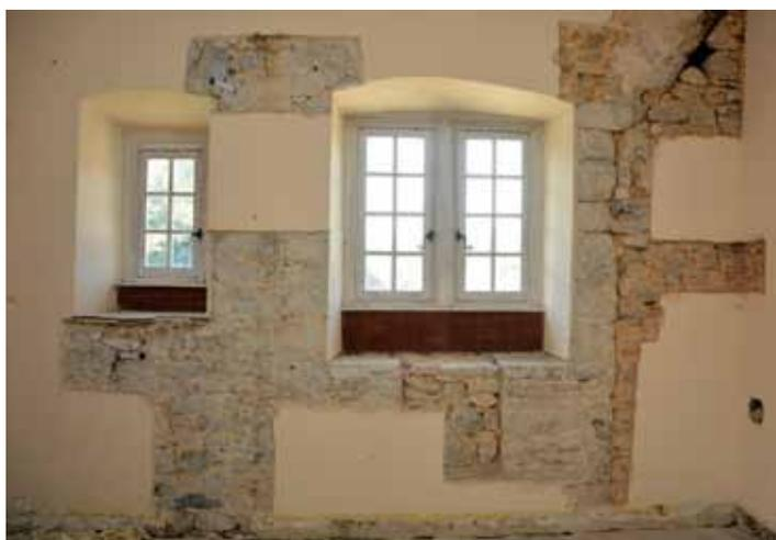
Détail de sondages dans des enduits du premier étage, avec mise en évidence de l'emplacement d'une cheminée primitive et des banquettes de la fenêtre de droite. Photo J.-L. Javaux © SPW
