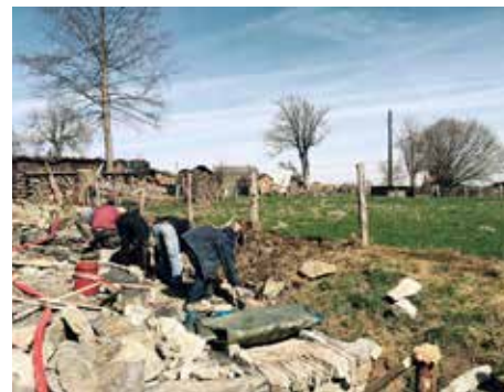
Chantier à Salle (Bertogne) © IPW
