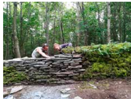
Chantier à Habay-la-Neuve © IPW
