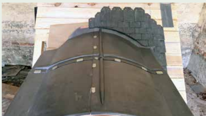
En haut, à gauche et à droite : Candidat « A » : vue en plan de la couverture cintrée en plomb (assemblage des tables, détails d'exécution, aspect) et détail de la mise en œuvre d'un capot de plomb à la jonction entre l'appui et le piedroit du châssis de la lucarne © SPW
