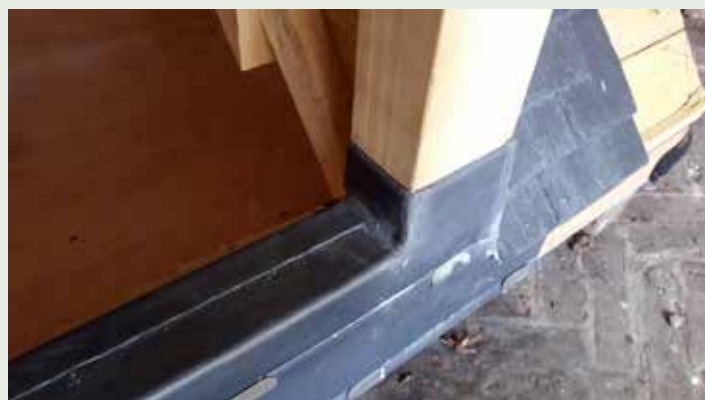
En haut, à gauche et à droite : Candidat « A » : vue en plan de la couverture cintrée en plomb (assemblage des tables, détails d'exécution, aspect) et détail de la mise en œuvre d'un capot de plomb à la jonction entre l'appui et le piedroit du châssis de la lucarne © SPW
