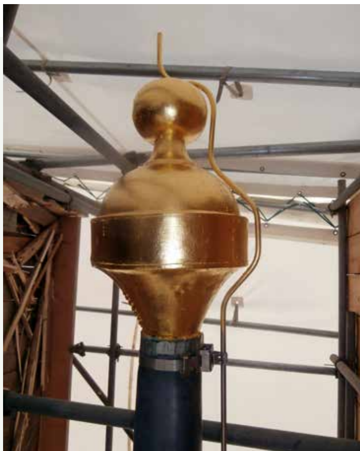
Contournement de l'élément de décor d'une croix et mise en dorure du conducteur pour tenter de le confondre avec cet élément © SPW/AWap
