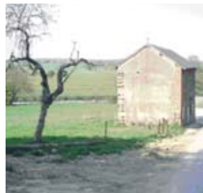
Florenville, La Poivrière. Vue de l'arrière du bâtiment. © C. Claeys
