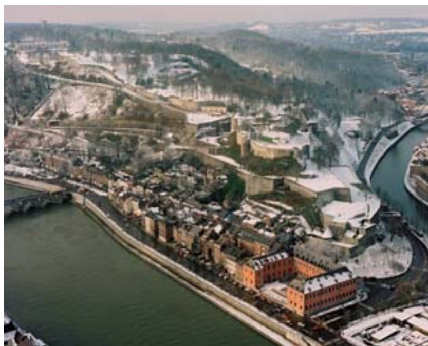
Vue aérienne de la Citadelle de Namur. G. Focant, DPat © MRW
