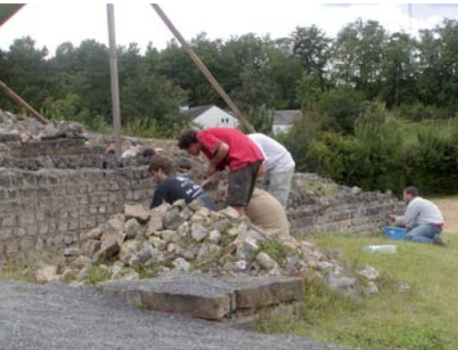
Intervention effectuée grâce à l'aide de l'IPW. © Malagne la Gallo-Romaine
