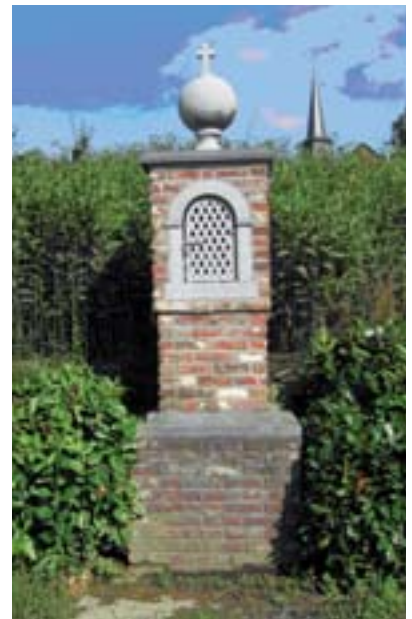
Gondregnies, rue Brisqué, la chapelle Saint Joseph complètement restaurée. © L. Devos
