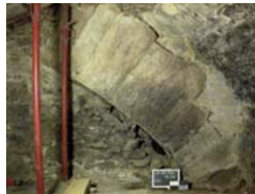
Photographie de l'arc de front conservé dans sa partie sud-ouest.
