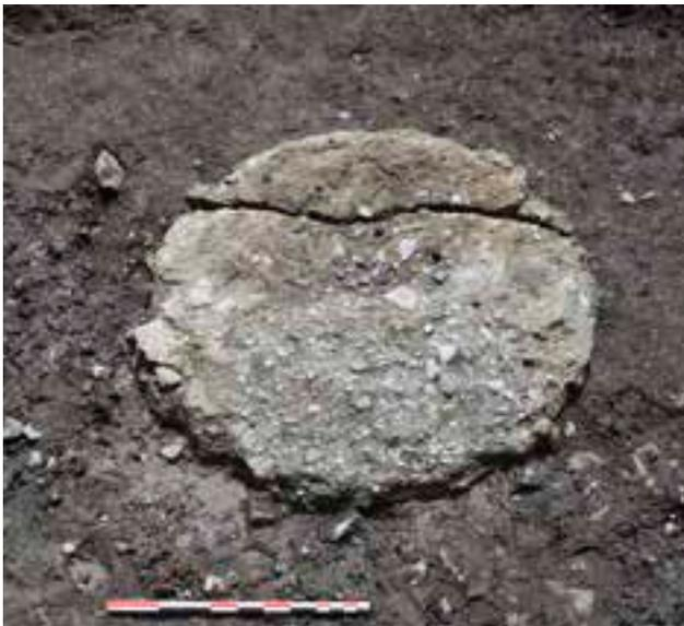
**Fig. 44.** Un malaxeur à mortier, en relation avec l'une des phases de construction de la Première Enceinte, indice d'un chantier d'envergure (Photo : É. Delaunois – AWaP).
