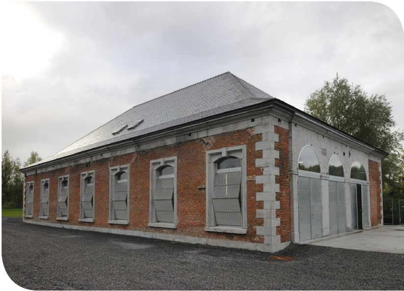
Bâtiments d'une ancienne carrière de pierre réaffectés en centre de formation « Pôle de la Pierre » à Soignies (province du Hainaut)
