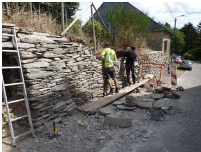
Stage pierre sèche 2018 à Tintange (Fauvillers), restauration d'un mur de soutènement © SPW-AWaP
