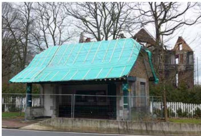
Aubette de Balmoral sous une bâche de protection nécessitée par une dégradation alarmante de la couverture. On distingue à l'arrière-plan le Golf-Hôtel détruit © RB
