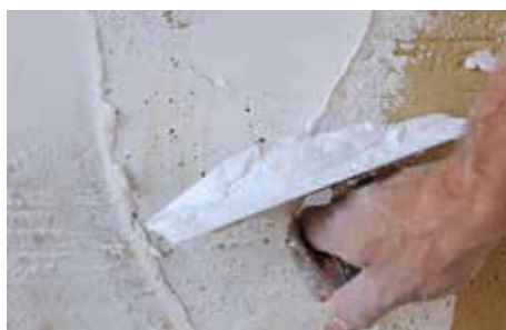
La chaux. G. Focant © SPW-AWap
