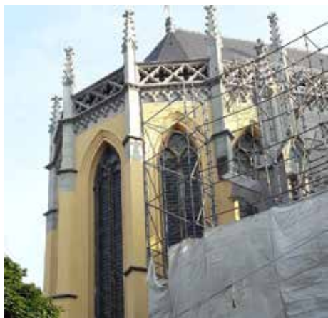
Chœur restauré de la cathédrale Saint-Paul à Liège. Raphaël Pilette © SPW-AWAp
