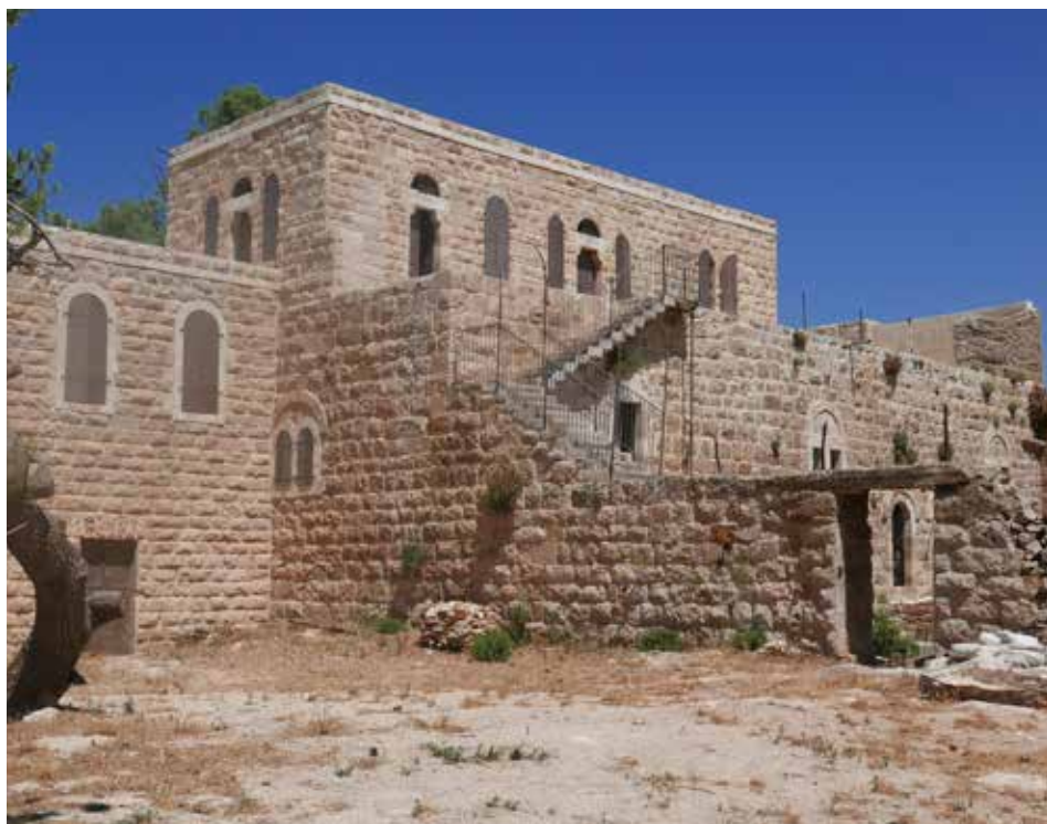
L'immeuble Al Huqqiyya à Qalandiya, en cours d'achèvement © SPW-AWaP
