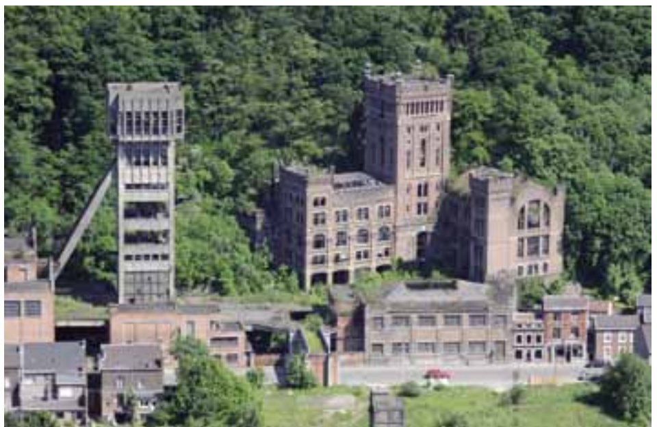
Photo G. Focant © SPW-Patrimoine
