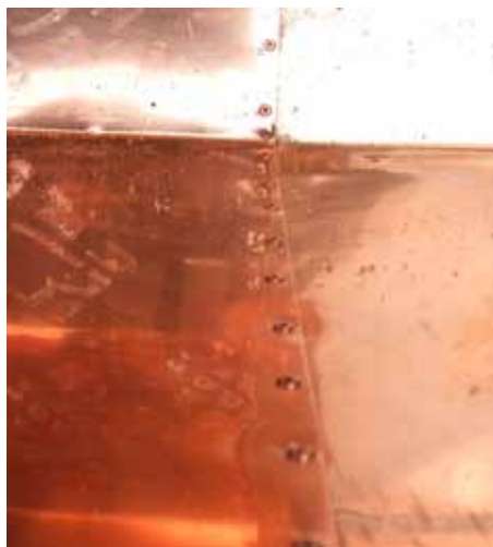
Rivetage préalable afin d'améliorer la résistance mécanique des assemblages © SPW
