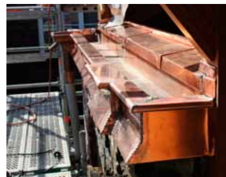
Chéneau type « encaissé » sur tête de maçonnerie © SPW
