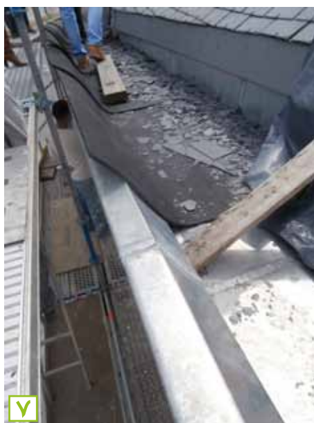
Pose d'un tapis en caoutchouc protégeant l'ensemble du bac de corniche © SPW
