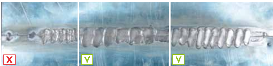
Au centre, soudure habituelle en fond de chéneau et à droite, soudure habituelle pour les relevés de chéneau © SPW
