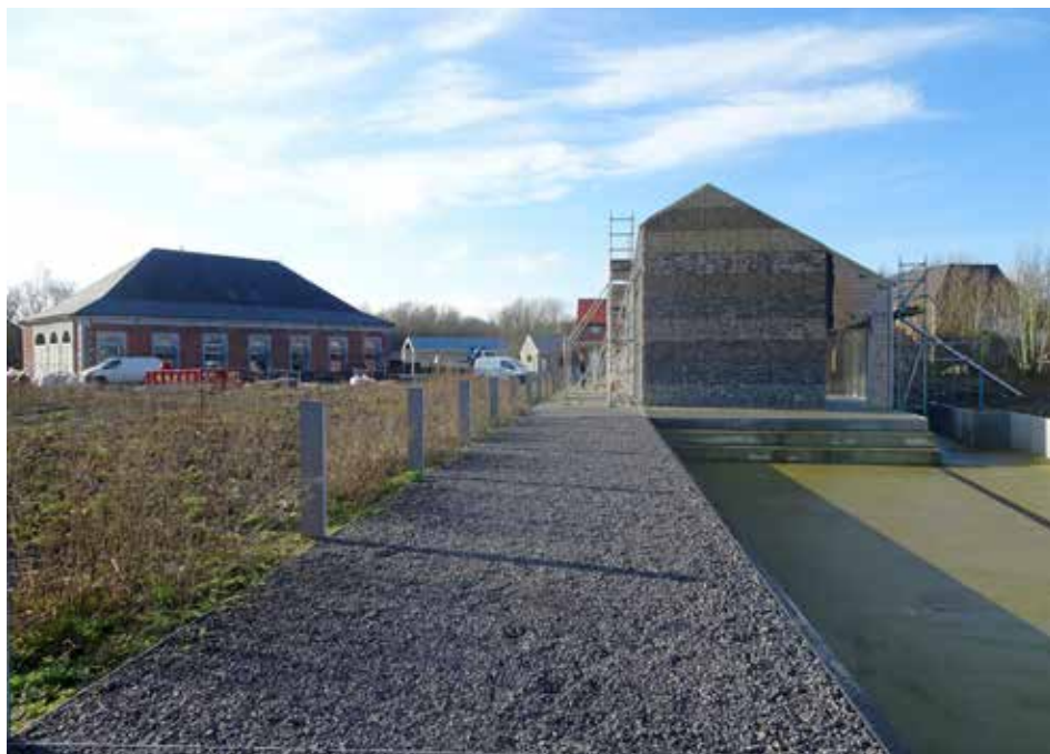
Vue du pignon nord en pierre des nouveaux ateliers © SPW-AWaP
