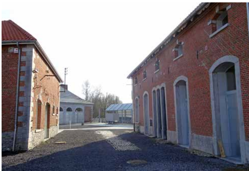
Vue de l'allée centrale entre l'ancienne forge et le magasin à clous © SPW-AWaP
