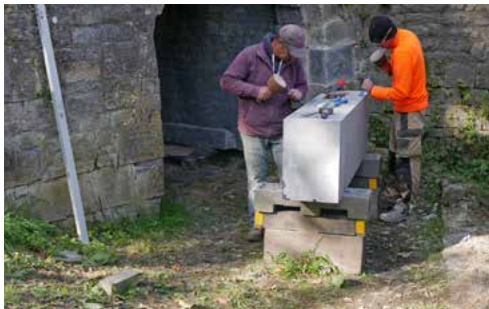
Formation OBS – Chantier-action au fort de Charlemont © SPW-AWaP
