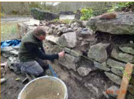
Chantier-action de restauration d'une maçonnerie en moellons de pierre bleue – Formateur : T. Taurand – © AWaP
