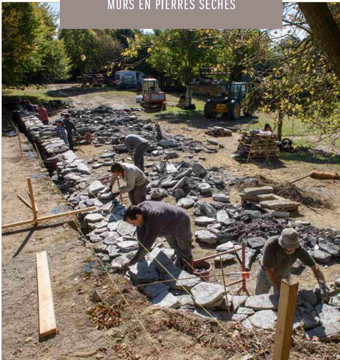
Construction d'un mur de soutènement à la ferme du Monceau, Vaux-sur-Sûre – Formateurs : B. Jardon et J.-C. Floris – FOCANT G. © SPW-AWap
