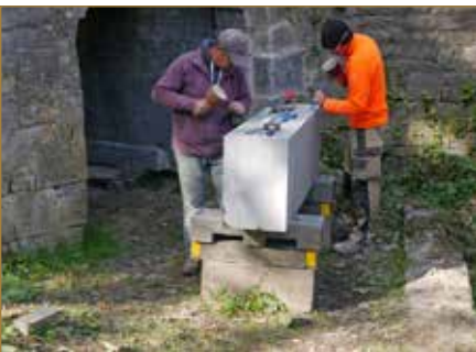
Formation OBS – Chantier-action au fort de Charlemont (septembre 2018) – Formateur : C. Mahy – © AWaP
