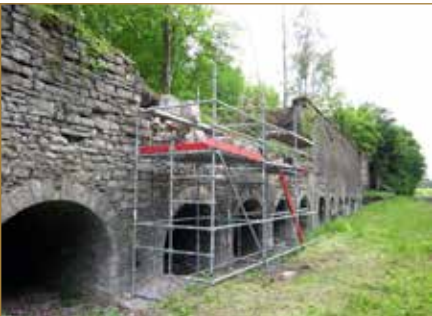
Restauration d'une maçonnerie ancienne à Cour-sur-Heure – Formateur : J. de Pierpont – © AWaP
