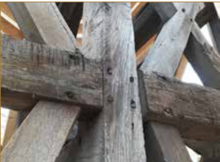
Détail de la structure du clocher de l'abbatiale de la Paix-Dieu – Formateur : P. Lemlyn – © AWaP
