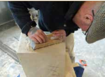
Taille d'une plate-bande en pierre tendre – Formateur : B. Potel – © AWaP
