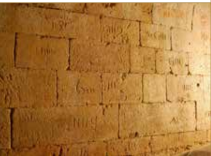
Parement en pierres de récupération à l'abbaye d'Orval – © DOPÉRE F.
