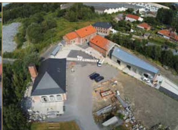
Vue aérienne du Pôle de la Pierre en cours de travaux – © AWaP
