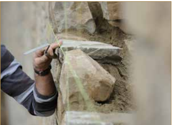
Restauration d'une maçonnerie ancienne – FOCANT G. © SPW-AWaP
