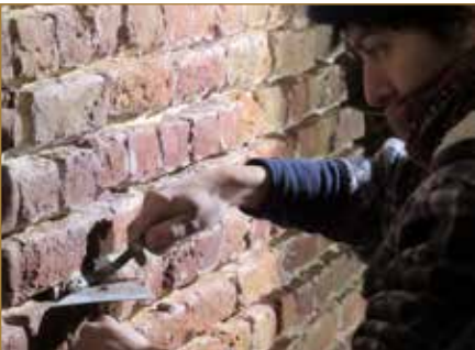
Restauration d'une maçonnerie à la chaux – Formateur : J. de Pierpont – © AWaP
