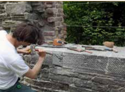
Réparation de pierre à l'abbaye de Villers-la-Ville – Formateurs : B. Potel, C. Mahy et J. de Pierpont – © AWaP
