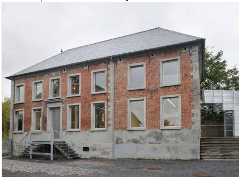
Le Pôle de la Pierre, vue générale des locaux administratifs – FOCANT G. © SPW-AWaP
