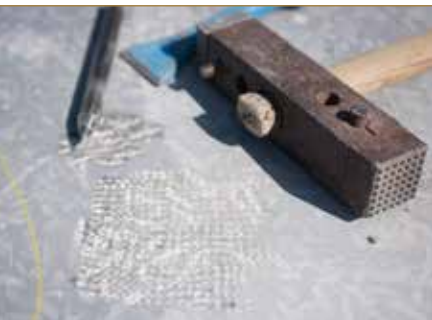
Travail des finitions d'un élément en pierre bleue – CARPENTIER J.-L. © SPW
