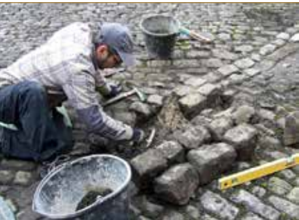
Restauration de pavage au château de Freÿr – Formateur : J. de Pierpont – © AWaP
