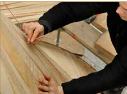
Réalisation du voligeage d'une couverture – Formateur : J.-J. Warzée – FOCANT G. © SPW-AWap
