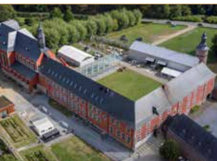
Vue aérienne du site de l'abbaye de la Paix-Dieu – Focant G. © SPW-AWaP
