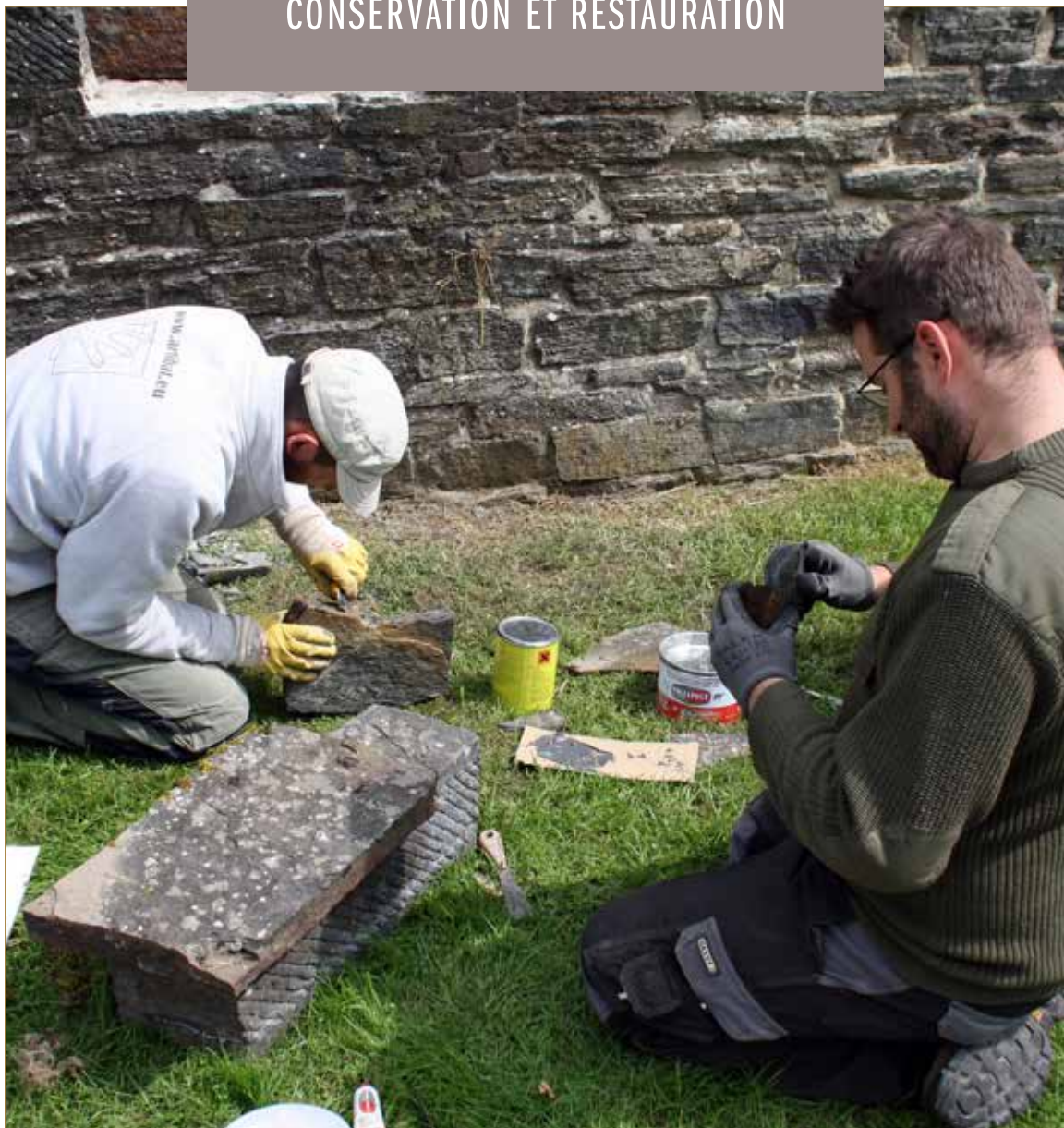
Réparation de pierres à l'abbaye de Villers-la-Ville – © AWaP
