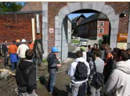
Visite du chantier du mur de clôture du Centre de la Paix-Dieu – © AWaP
