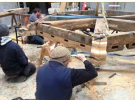
Restauration de la charpente du clocher de l'abbatiale – Formateur : P. Lemlyn – © AWaP
