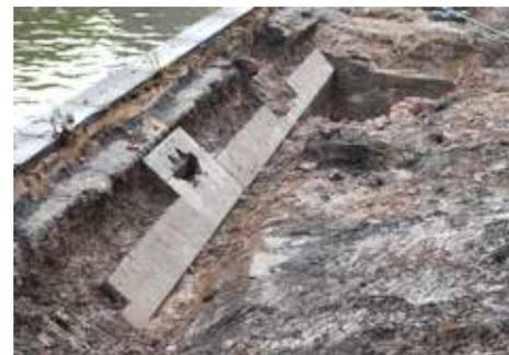
Fig. 3 Vue du batardeau. Au centre, dispositif du système d'évacuation des eaux © SPW-AWaP
