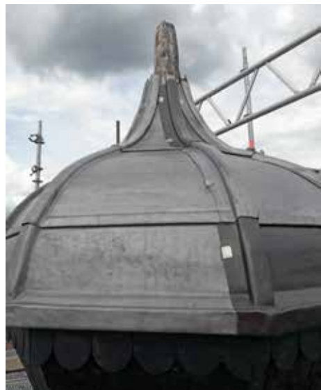
Église des Bénédictines, photos du chantier © SPW-AWap
