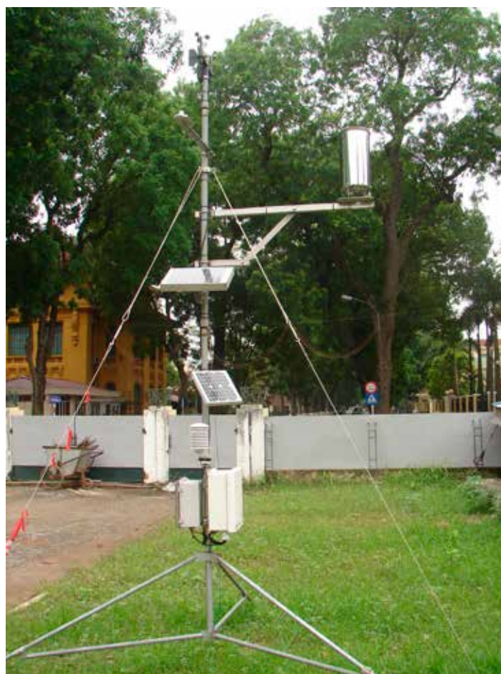
Installation d'une mini station météorologique © SPW-AWaP
