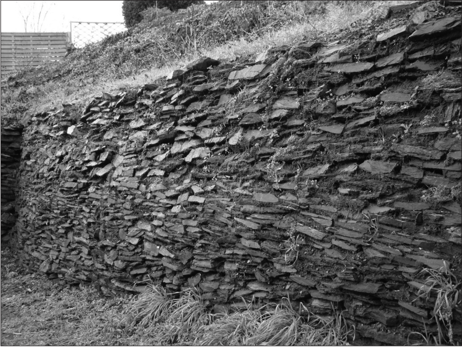
En bordure du chemin longeant le ruisseau de Cœurq, côté rive droite. Un des nombreux murets de pierres sèches retenant les "terrils" et motte de déchets de façonnage de l'ancienne carrière de Stéhoux. (Photo G. Bavay)
