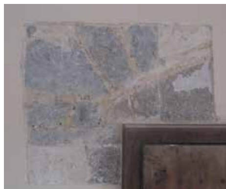
Décapage d'enduit intérieur au niveau de la latrine appendue en façade sud © GdG architects
