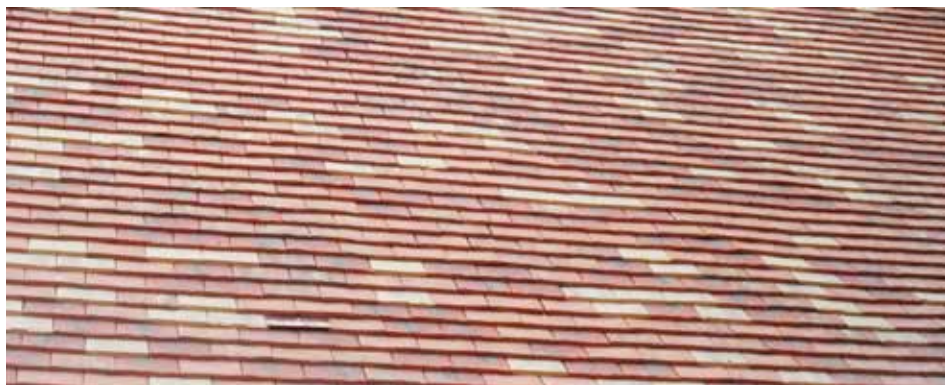
Plan carré en tuiles plates avec chatière en cuivre - église de Vauxrezis, dans l'Aisne, France © DR
