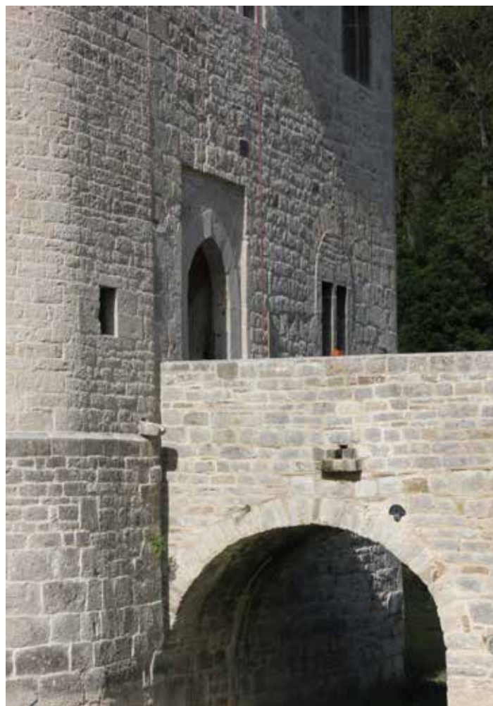
L'entrée principale et sa feuillure, témoin de la passerelle relevable disparue © GdG architects
