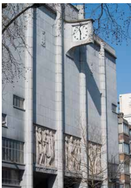
Le Lycée Léonie de Waha, façade écran sur le boulevard d'Avroy à Liège. G. Focant © SPW-AWAP
