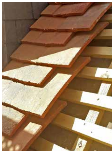
Raccord tuile plate avec lucarne en ardoise - chantier quai des salines 27 à Tournai © SPW-AWaP
