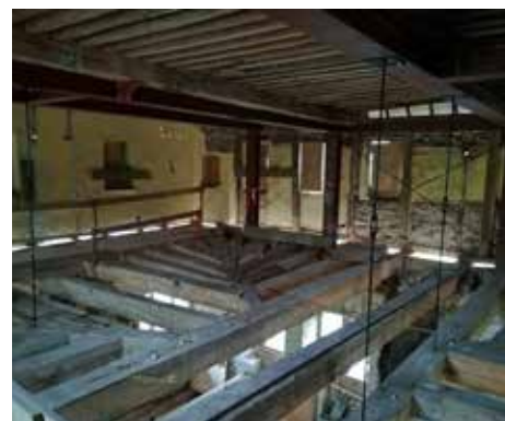
Structure rayonnante soutenant l'étage en pans de bois après suspension par tirants aux portiques métalliques © GdG architects
