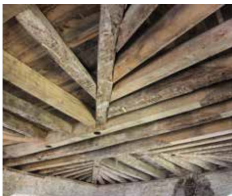
Structure rayonnante soutenant l'étage en pans de bois après suspension par tirants aux portiques métalliques © GdG architects
