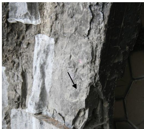
Fig. 16 Éclatement de la pierre (Porte Mantile, bandeau cintré).
