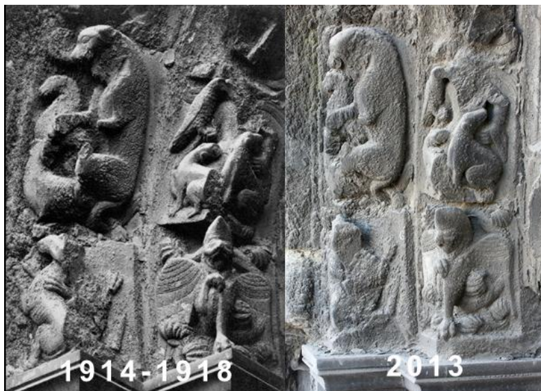
Fig. 9 Porte Mantile, partie gauche de l'archivolte : état de conservation en 1914-1918 et en 2013. © KIK-IRPA, Bruxelles, A8030 et X049756.
