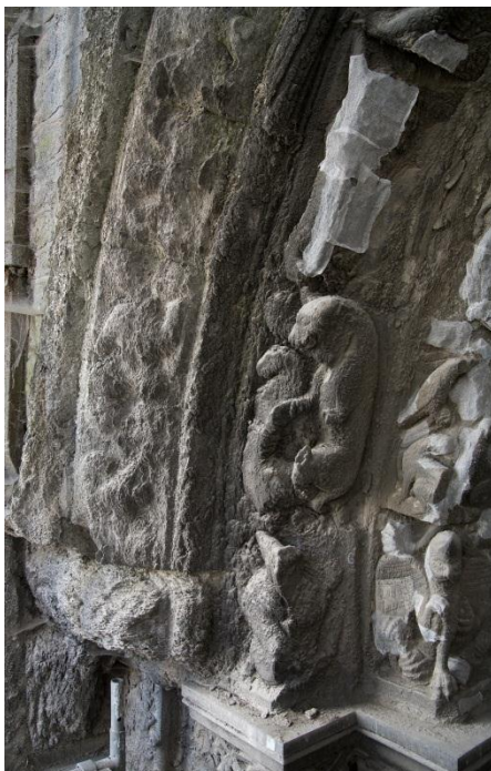
Fig. 27 Détail de la partie inférieure du côté droit de la voussure trilobée : contraste entre les sculptures originales encore présentes et la perte de sculpture à l'extérieur de la voussure.
