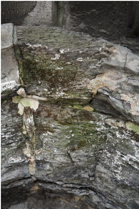
Fig. 23 La colonisation biologique sous forme de lichens, mousses et algues vertes du cordon larmier (Porte Mantile)
