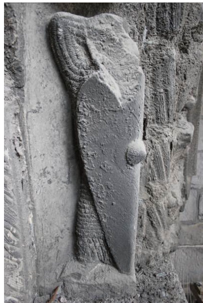
Fig. 34 Détail du manque à la tête de la sculpture de la voissure trilobée (Porte du Capitole).
