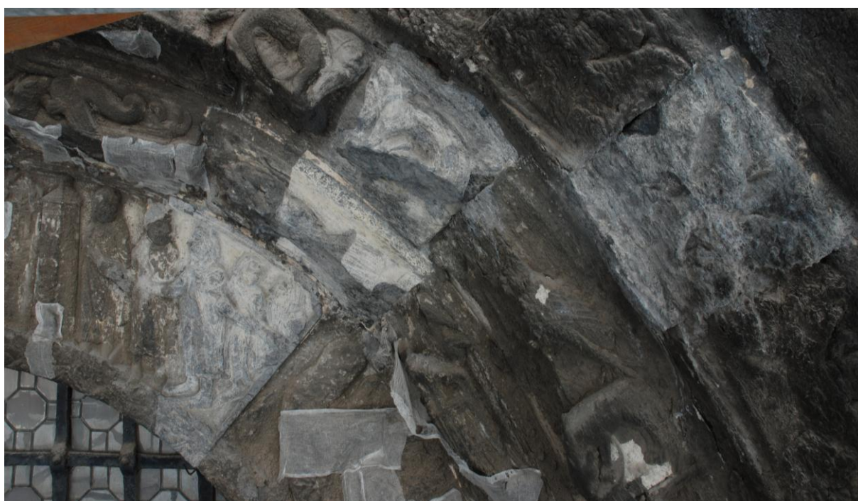
Fig. 47 et 48 Zone de test avant et après traitement
