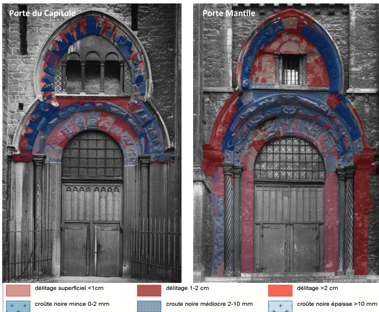
Fig. 30 Cartographies générales des phénomènes de délitage et de formation de croûtes noires avec les différentes catégories qui montrent l'ampleur et l'intensité du phénomène.
