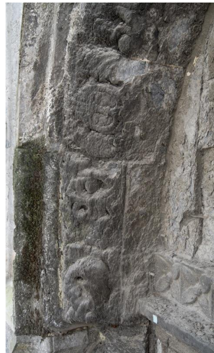
Fig. 27 Détail de la partie inférieure du côté droit de la voussure trilobée : contraste entre les sculptures originales encore présentes et la perte de sculpture à l'extérieur de la voussure.
