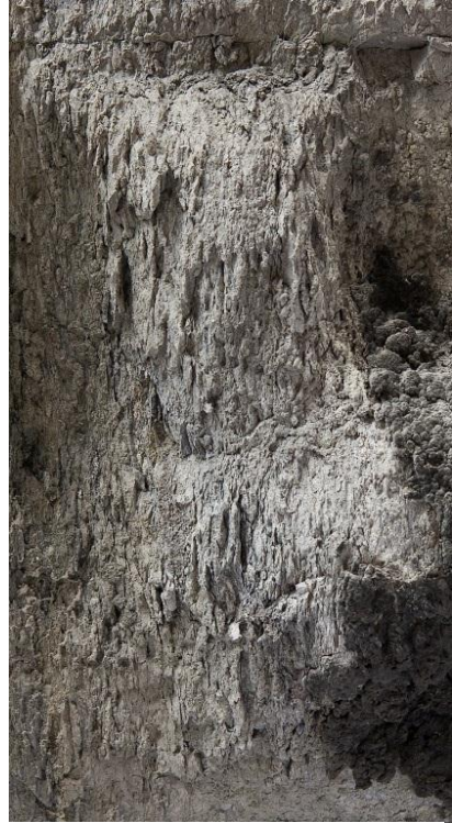
Fig. 19 Délitage de 1 à 2 cm de profondeur.
