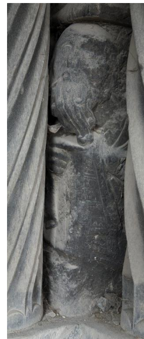
Fig. 22 Dépôt de poussières formé sur les sculpture du piédroit (Porte Mantile).
