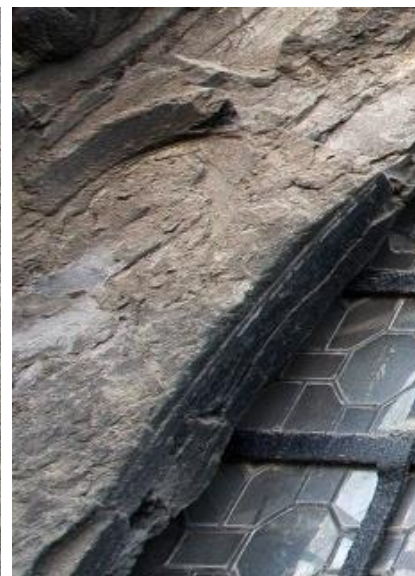
Fig. 13 Développement d'une cassure le long des plans de faiblesse lorsque ces éléments structuraux sont orientés verticalement (Porte Mantile, bandeau cintré).
