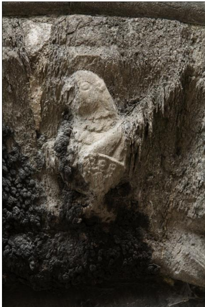
Fig. 25 Détail de la voussure trilobée (bloc de pierre VT20) : la distinction entre le noyau compact et les bords schisteux est bien visible.
