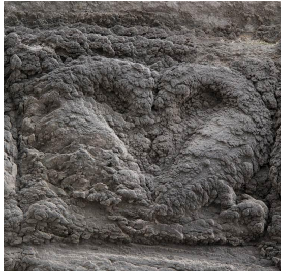
Fig. 21 Croûte noire bourgeonnante (Porte Mantile, voussure trilobée).
