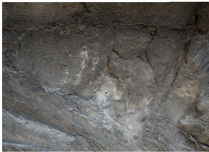
Fig. 20 Délitage de plus de 2 cm de profondeur.
