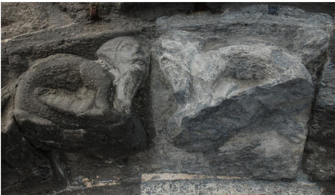
Fig. 55 Détail de la zone de test 3 après traitement
