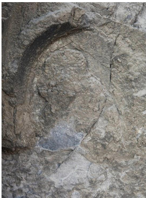
Fig. 15 Fente d'une largeur supérieure à 1 mm (Porte Mantile, tympan supérieur).
