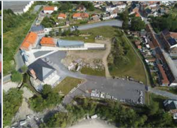
Vue aérienne du Pôle de la Pierre à Soignies © AWaP
