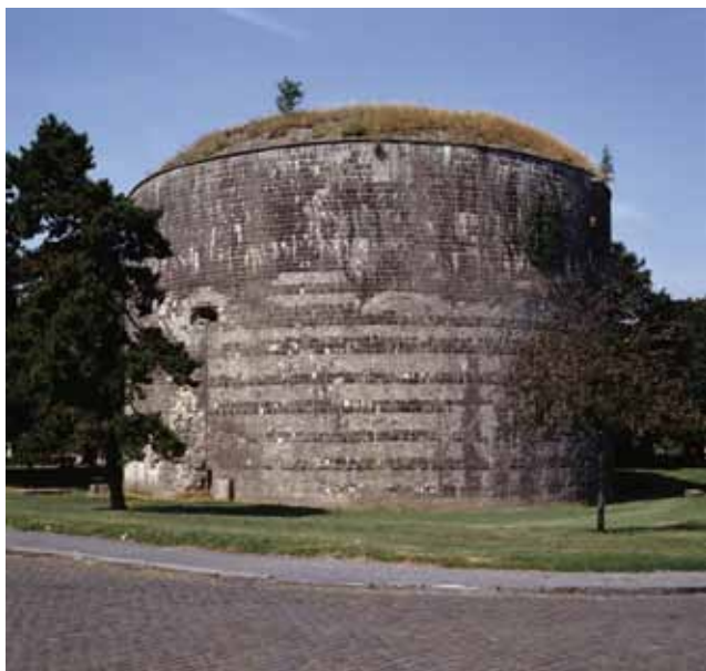
Figure 10 : (Voir planche couleur) Tour Henry VIII à Tournai, Belgique (Guy Focant © SPW).
