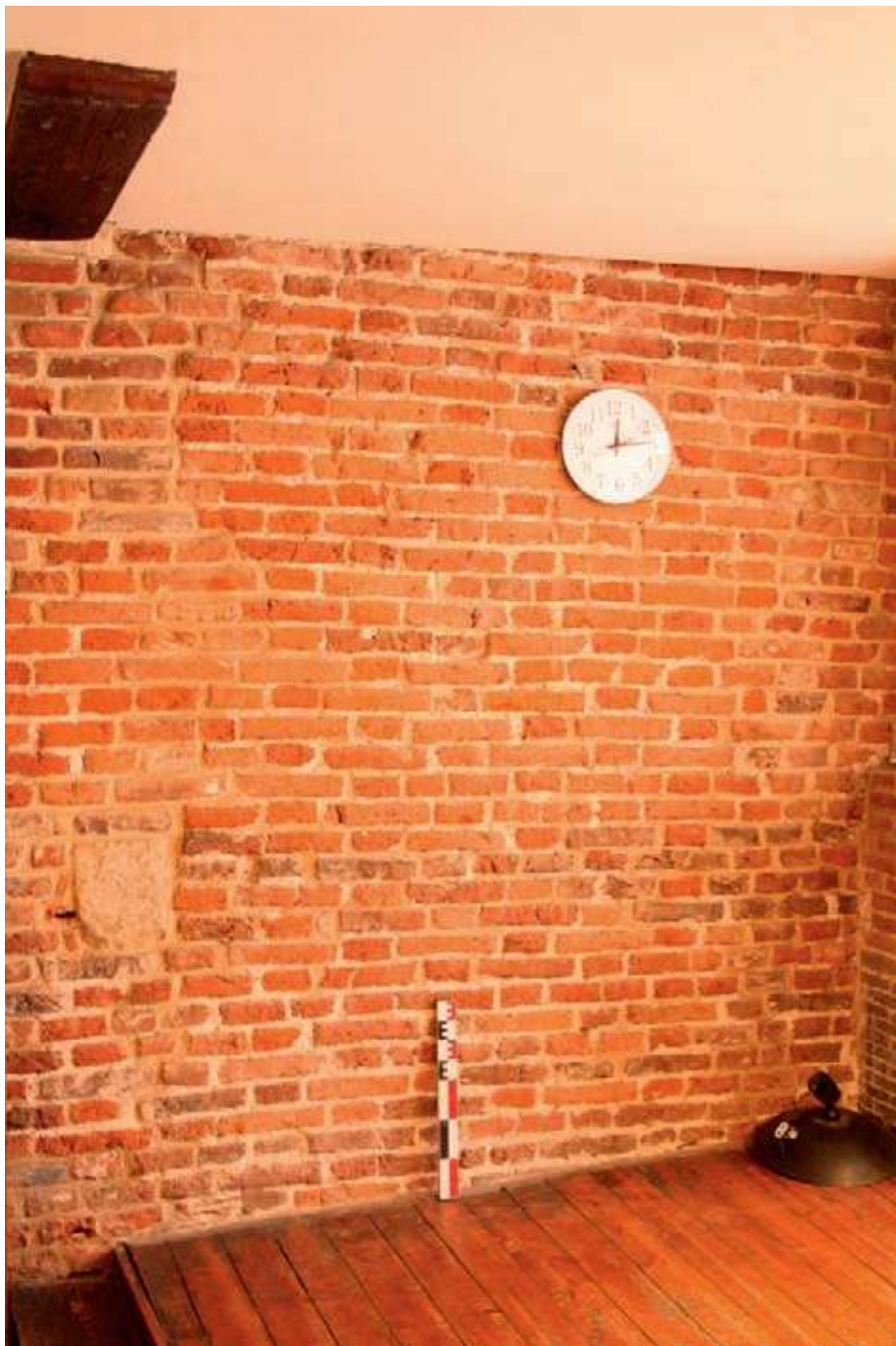
Fig. 10. Rue de Laeken 120, Bruxelles, mur gouttereau septentrional daté du XVI e siècle (P. Sosnowska © CReA-Patrimoine/ULB)
