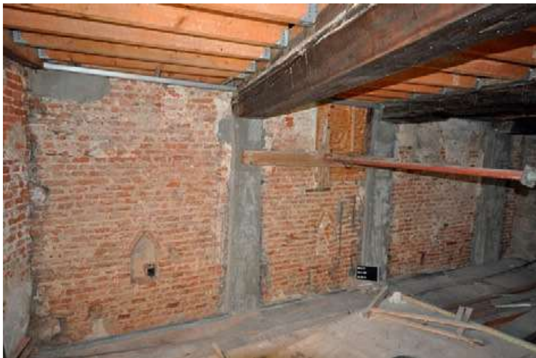
Fig. 4. Rue de Flandre 180, Bruxelles, mur gouttereau oriental avec niches datées de la fin du XIV e ou du début du XV e siècle (S. Byl, P. Charruadas, C. Devillers, P. Sosnowska © DMS/SPRB - CReA-Patrimoine/ULB)
