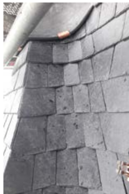
Montigny le tilleul - Noves rondes sur lucarne et versant de couverture. G. Focant © SPW-AWaP
