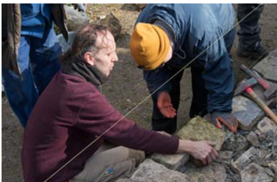
Chantier de formation à la pierre sèche à Crupet, 2020. G. Focant © SPW-AWaP
