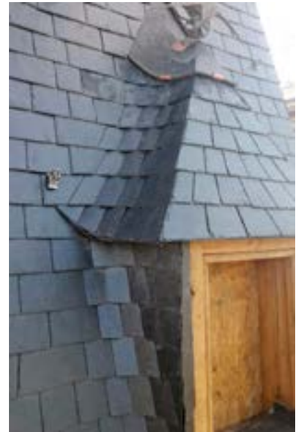
Montigny le tilleul – Noues rondes sur lucarne et versant de couverture. G. Focant © SPW-AWaP
