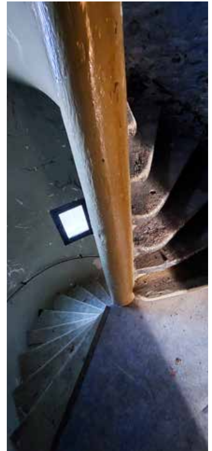
Vue intérieure de la tourelle, Soignies. © AWaP
