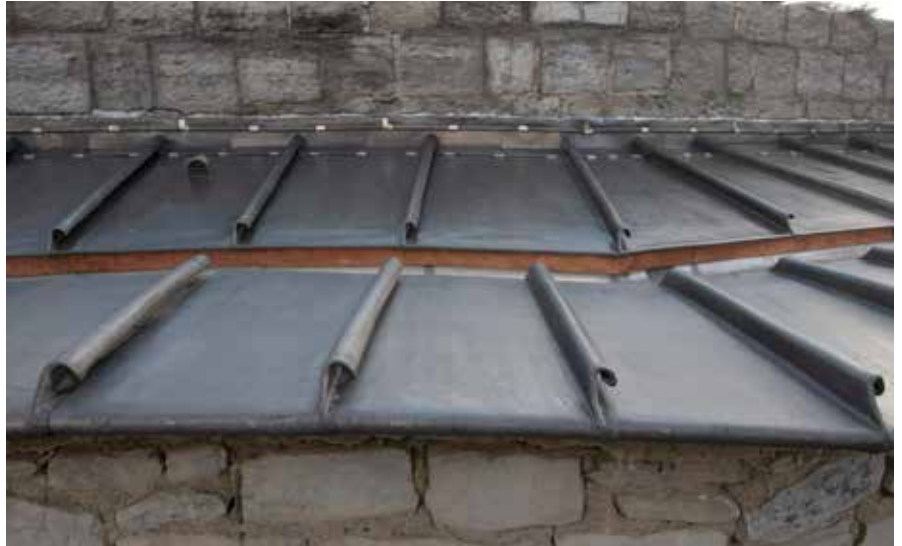
Vue des assemblages des tables de plomb entre elles selon la méthode de « l'ourlet roulé ». Sur la partie supérieure du cliché, on observera également l'étanchéisation de la bande soline en plomb, engravée dans la maçonnerie, à l'aide de laine de plomb matée. G. Focant © SPW-AWaP
