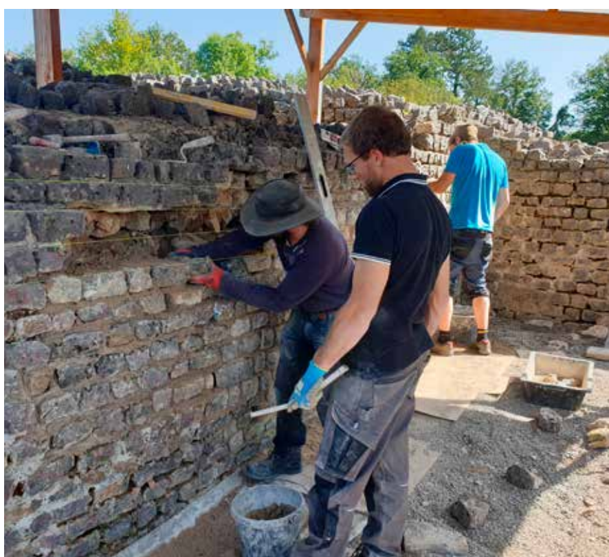
Restauration du mur d'une cave de la villa gallo-Romaine du site de la Malagne, Rochefort. © AWaP
