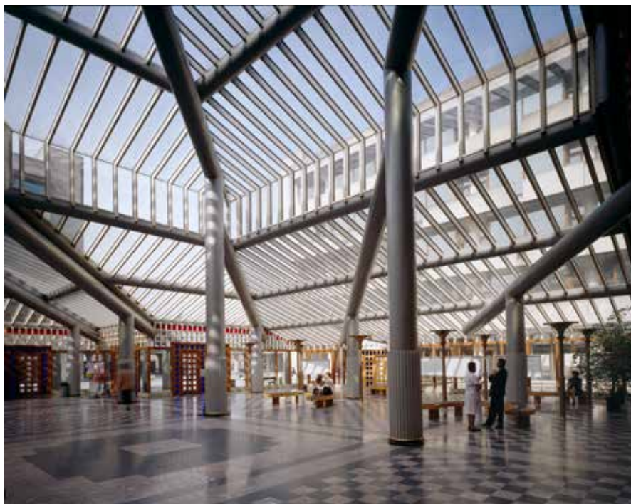
Verrière du CHU au Sart-Tilman, Liège. G. Focant © SPW-AWaP
