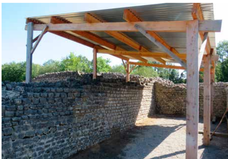
Le mur consolidé après à peine quatre jours de formation. © AWAP
