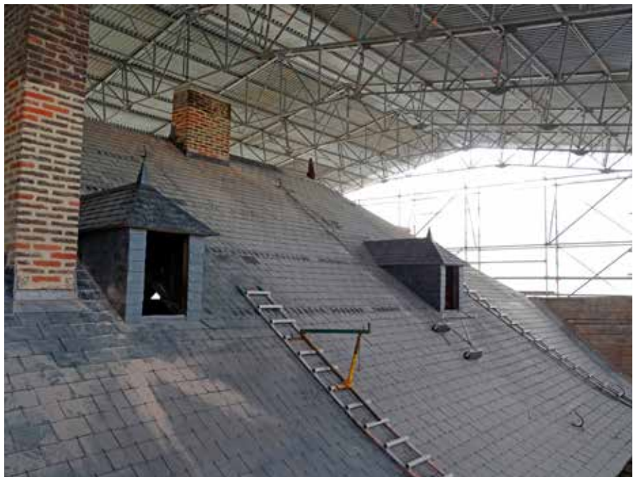
Réfection complète de la toiture avec pose des nouvelles ardoises. © AWaP
