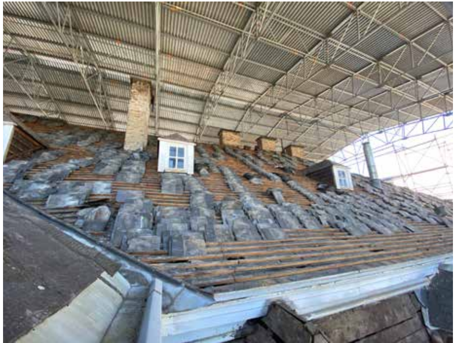
Dégarnissage en cours de l'aile principale. © A. Brismé
