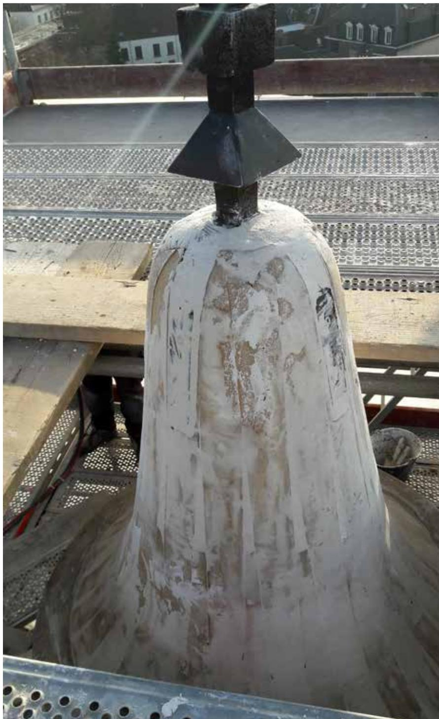
Chapelle des visitandines, Mons. Préparation à l'aide de plâtre THD du support qui recevra la pré-embase de plomb. Mise en place d'un élément en forme de pyramidon soudé au pied de la hampe de la croix pour assurer le raccord d'étanchéité avec la pré-embase. © AWaP
