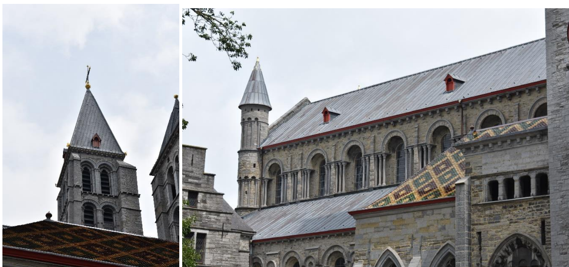
Fig. 2 et 3 : Nouvelle couverture en plomb des parties romanes de la cathédrale Notre-Dame, 2021 © Auteur
