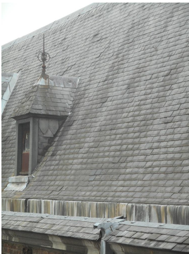
Fig. 13 : La Halle aux draps, dans son état actuel, est le fruit d'une reconstruction postérieure à l'incendie de mai 1940. Les éléments de couverture et de décor des lucarnes, chéneaux et descentes d'eau, sont tous en ferronnerie et zinc © Auteur
