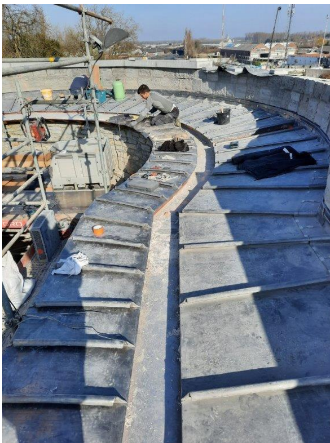
Fig. 1 : Etanchéité au plomb de la tour du Bourdiel, Pont des Trous, 2021 © AWAP – Jean-Christophe Scaillet
