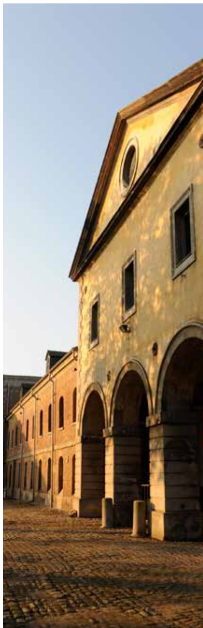
Entrée monumentale du Grand-Hornu, Boussu. G. Focant © SPW-AWaP
