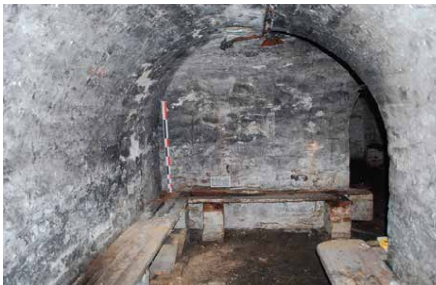
Abri antiaérien, vue des salles 3 et 2, Tournai. © SPW-AWaP
