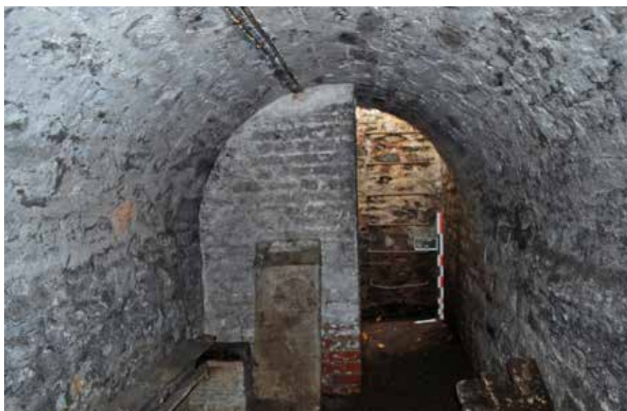
Abri antiaérien, vue du fond de la salle 3 avec le réduit à gauche et l'issue de secours à droite, Tournai. © SPW-AWaP
