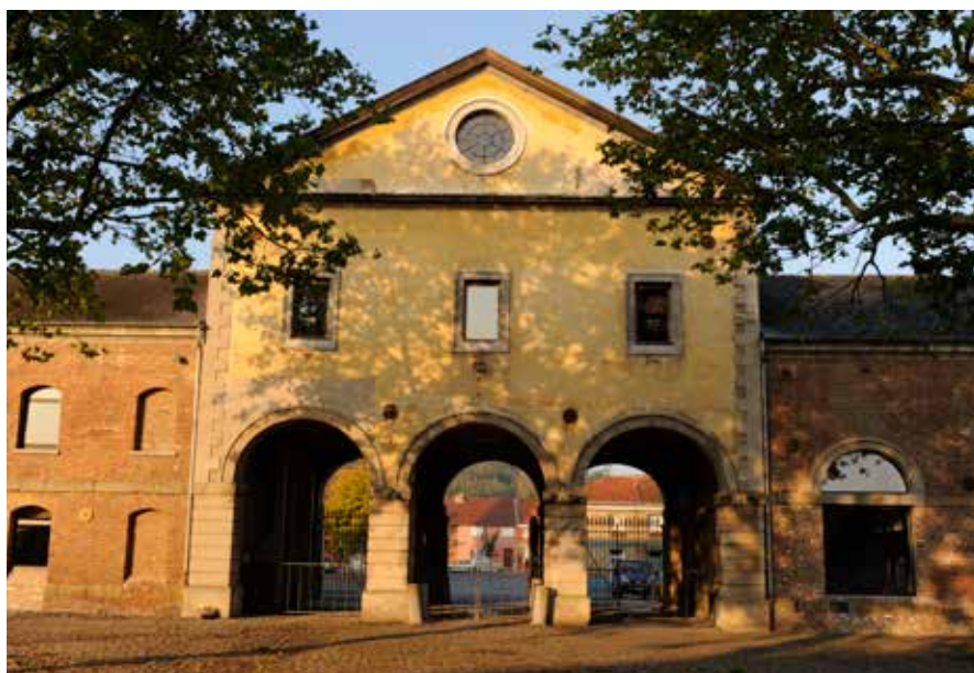
Entrée monumentale du Grand-Hornu, Boussu. G. Focant © SPW-AWaP
