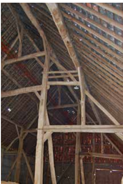
Vue intérieure de la grange à la Dîme, Orp-Jauché. V. Léonard © AWaP
