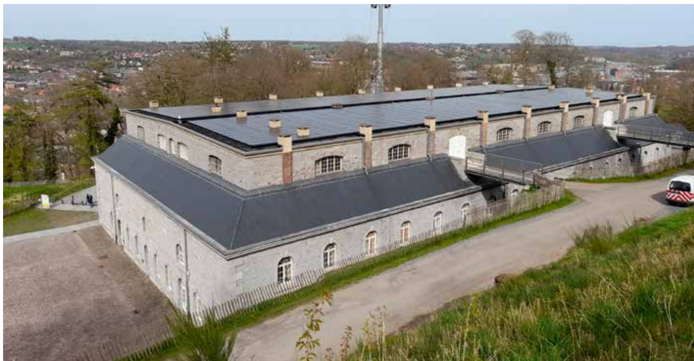
Panneaux photovoltaïques sur la toiture de la caserne de Terra Nova, Namur. © Ville de Namur
