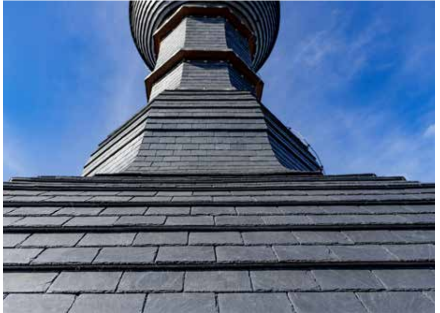
Vue en contre plongée de la partie supérieure du clocher, à partir du lanterneau octogonal. On appréciera l'alignement parfait des liaisons verticales entre les ardoises gironnées suivant une ligne de fuite matérialisée par l'axe de symétrie du clocher. V. Rocher © AWaP
