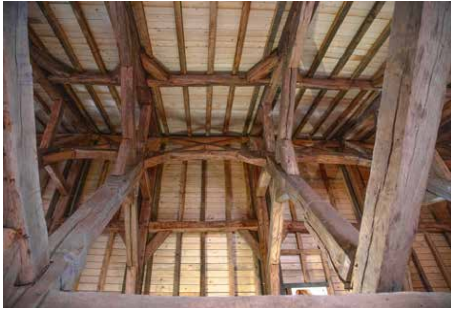
Charpente du XVI e siècle restaurée, château de Jehay (juin 2021). © Provincedeliege-Dép-Comm.
