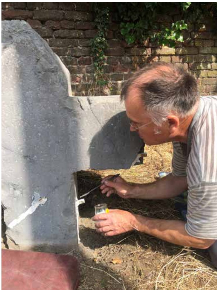
Application par Pierre Boreux de la colle époxyde dans les microfissures de la croix, Jambes. © Société archéologique de Namur
