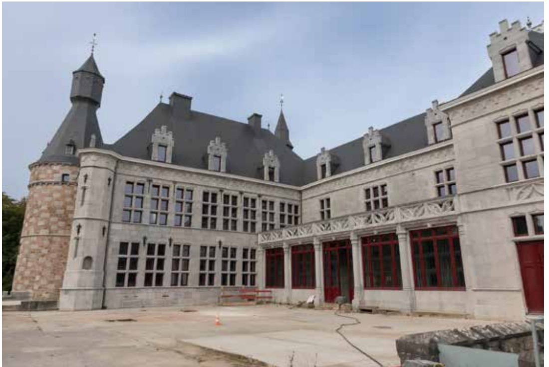
Cour d'honneur du château de Jehay après évacuation de la grue et des échafaudages (septembre 2023).
