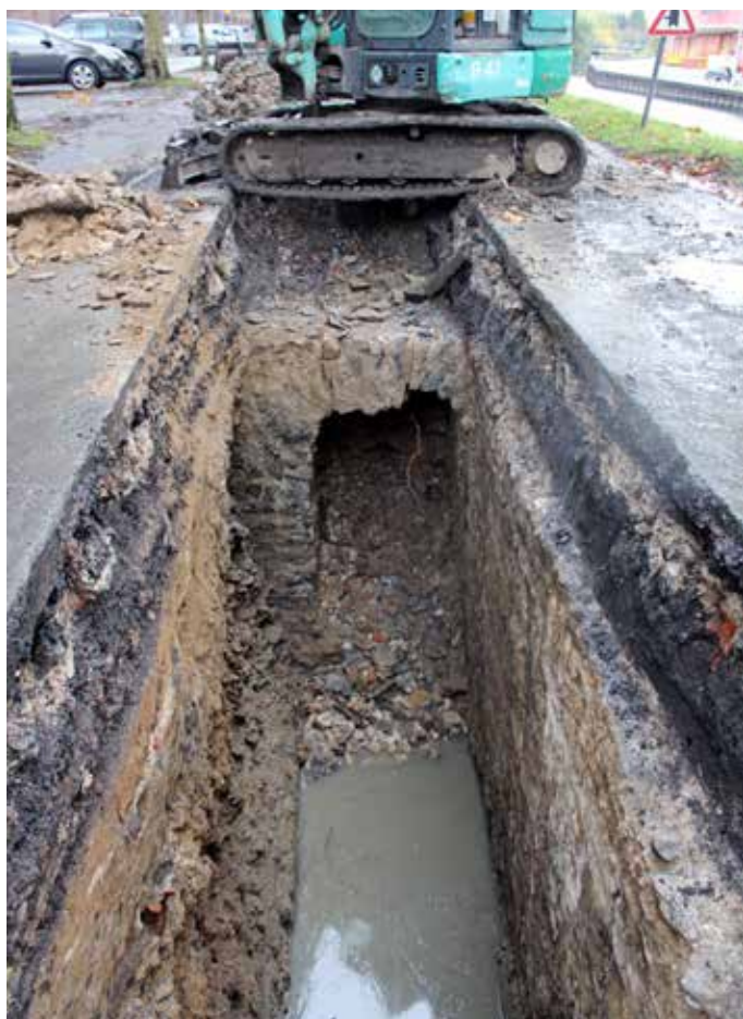
Contrefort percé d'une baie adossé à la face du bastion d'Artois, Ath.
