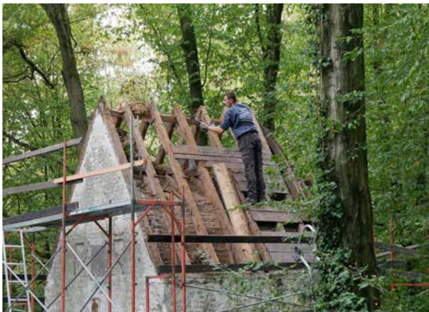
Restauration de la couverture de la chapelle Saint-Léonard, Thuin. © B. Marchoul
