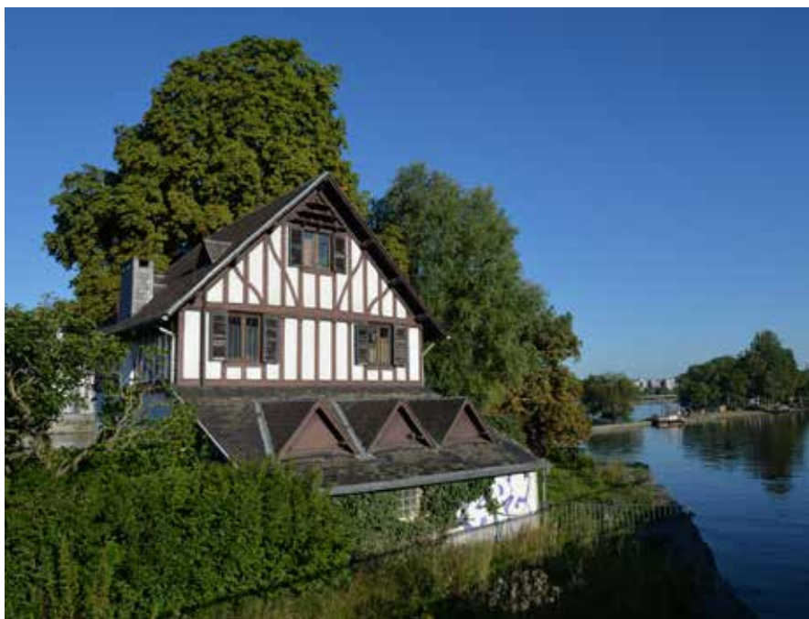
Maison du barragiste Monnier à Fétinne (Liège), une œuvre de Georges Hobé. Façade est : remise avec toiture à trois outeaux, habitation avec pignon à pan de bois et pigeonnier intégré. août 2023. © R. Balau.
