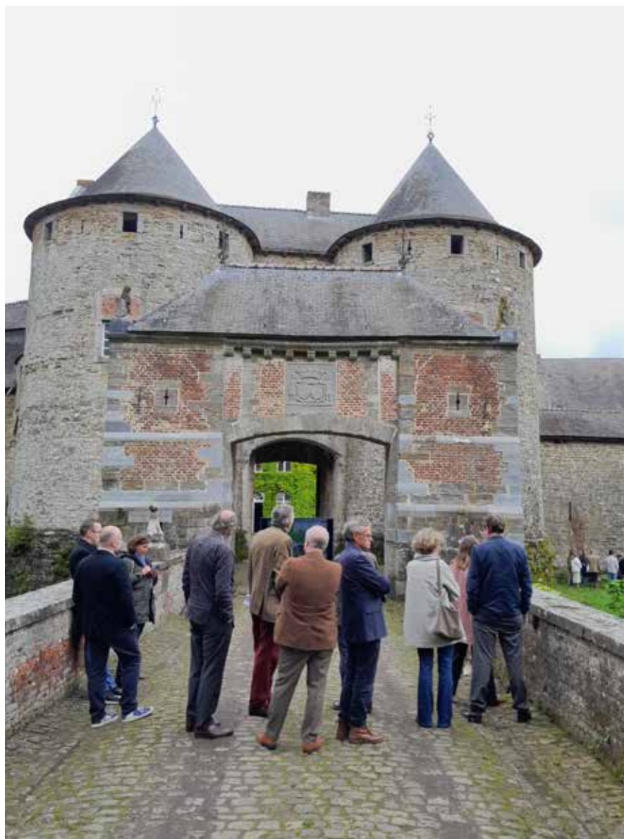
Atelier pratique en petits groupes (maçonnerie, couverture et zinguerie, charpente), château de Corroy-le-Château. © AWaP
