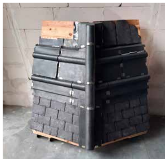
Pièce d'épreuve du membron pour le lot couverture de la basilique Notre-Dame de Bon-Secours, Péruwelz. © AWaP
