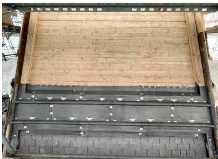
Réalisation du membron lors du chantier de la basilique Notre-Dame de Bon-Secours, Péruwelz. © AWaP
