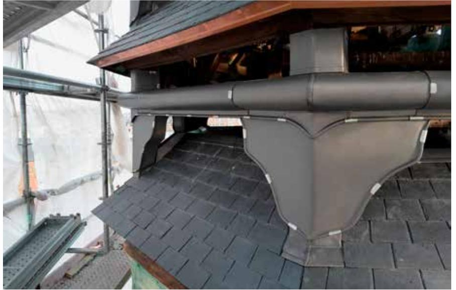
Habillage des poteaux et raccords d'étanchéité à l'aide de tables de plomb de 3 mm d'épaisseur, Binche. © AWaP
