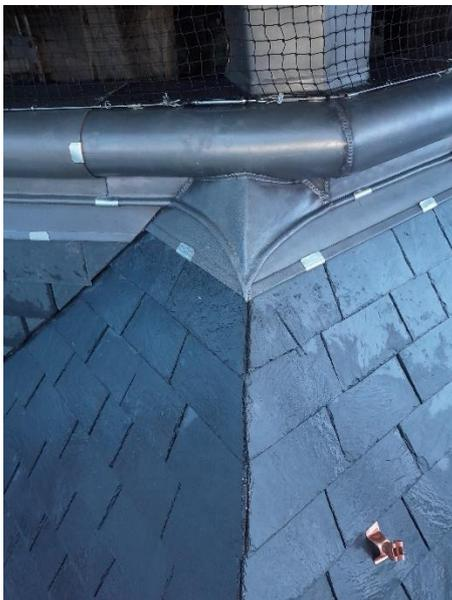
L'ensemble des lucarnes, hors beffroi, ont été également recouvertes à l'aide d'ardoises naturelles. Leur faîtage est réalisé selon le principe du faîtage « trois pièces » en plomb. Les arêtières sont gironnées à l'instar de la croupette offrant un aspect final particulièrement élégant. Les piédroits, traverses et pieds de lucarnes ont été recouverts de plomb en veillant à bien épouser, par un emboutissage délicat, les discrètes moulures imprimées dans le bois.
