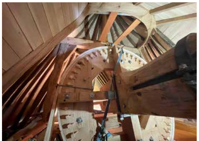
Rouet replacé dans la toiture du moulin.
