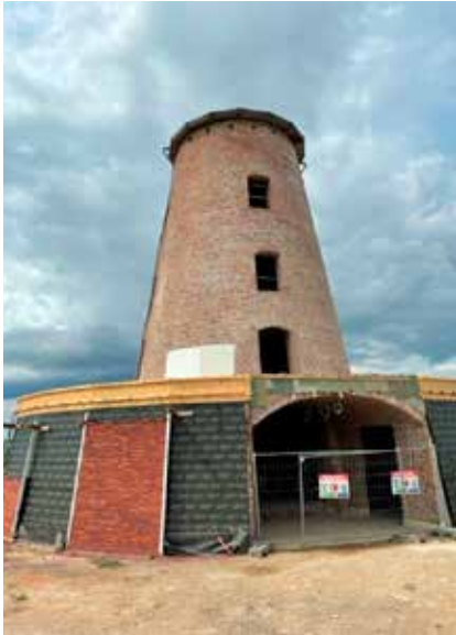
Parement contemporain en cours d'élaboration avec essais de la teinte de la peinture silicate.
