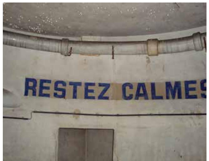
Abri anti-aérien avant restauration, Cité Miroir, Liège. © AWaP
