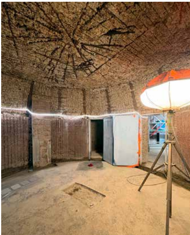
Abri anti-aérien en cours de chantier fin mars 2025, Cité Miroir, Liège. © AWaP
