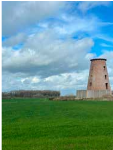
Vue du moulin au stade de l'élaboration des voiles béton (galerie circulaire). © AWaP
