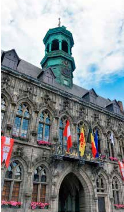
Façade et toiture avant rénovation, hôtel de ville, Mons. © Ville de Mons - C. Forton
