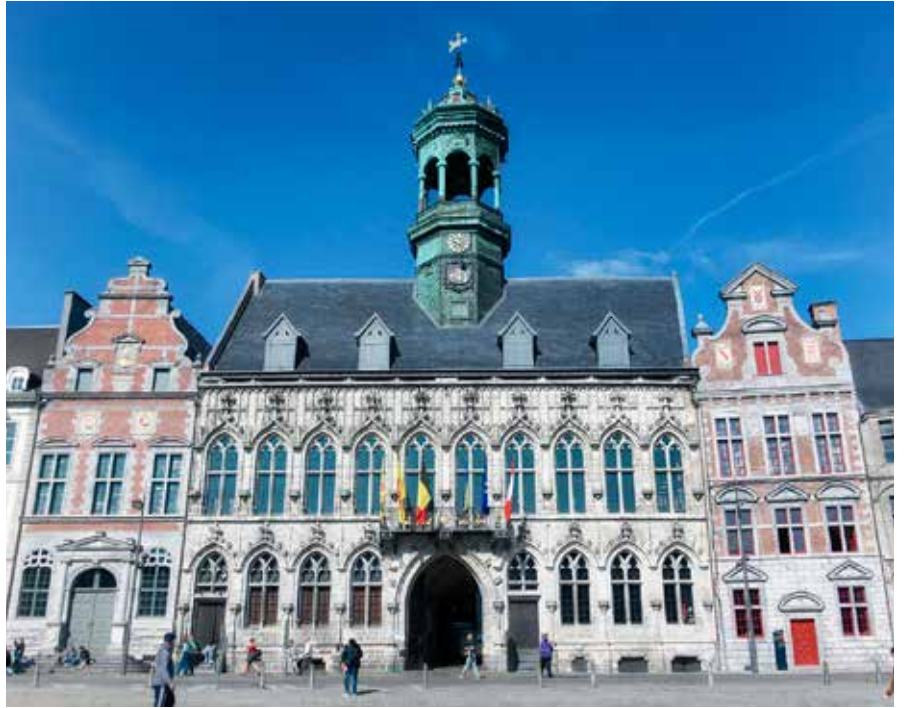
Façade et toiture après rénovation, hôtel de ville, Mons. © Ville de Mons - C. Forton
