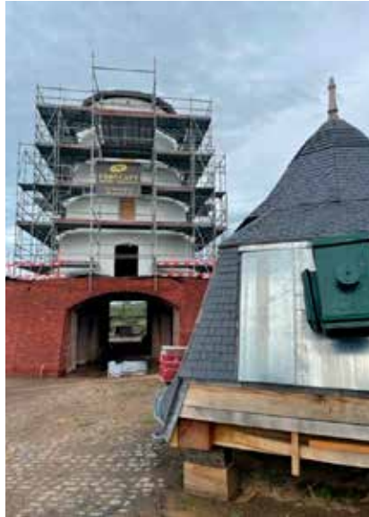
Vue du moulin avant repose de la toiture restaurée.
