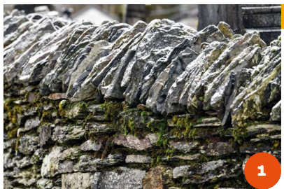
1 Détail d'un mur en pierre sèche à Ollomont (Houffalize, province du Luxembourg).
