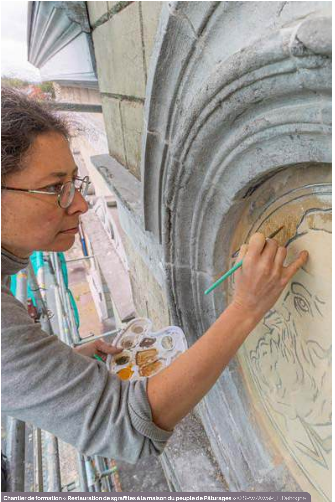
Chantier de formation « Restauration de sgraffites à la maison du peuple de Pâturages » © SPW/AWaP_L Dehogne
