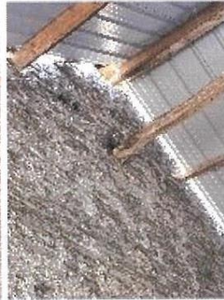
Mur Est de la bâtisse Déchaussement de la charpente
