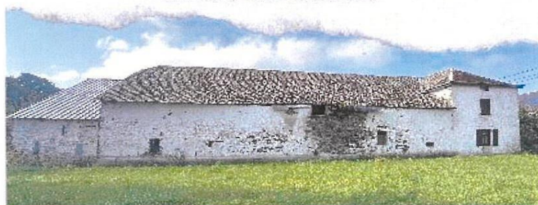
Affaissement du mûr arrière du bâtiment.
