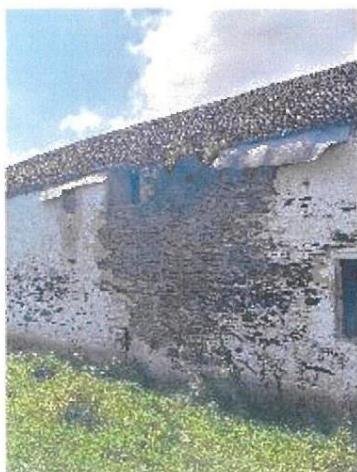
Affaissement du mûr arrière du bâtiment.
