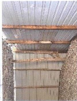
Mur Est de la bâtisse Déchaussement de la charpente
