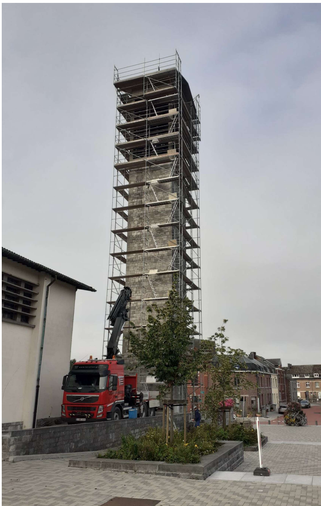
TOUR-CLOCHER : TRAVAUX 2021 : RESTAURATION DES VENTELLES AVEC RECOUVREMENT PAR DES FEUILLES DE MÉTAL
