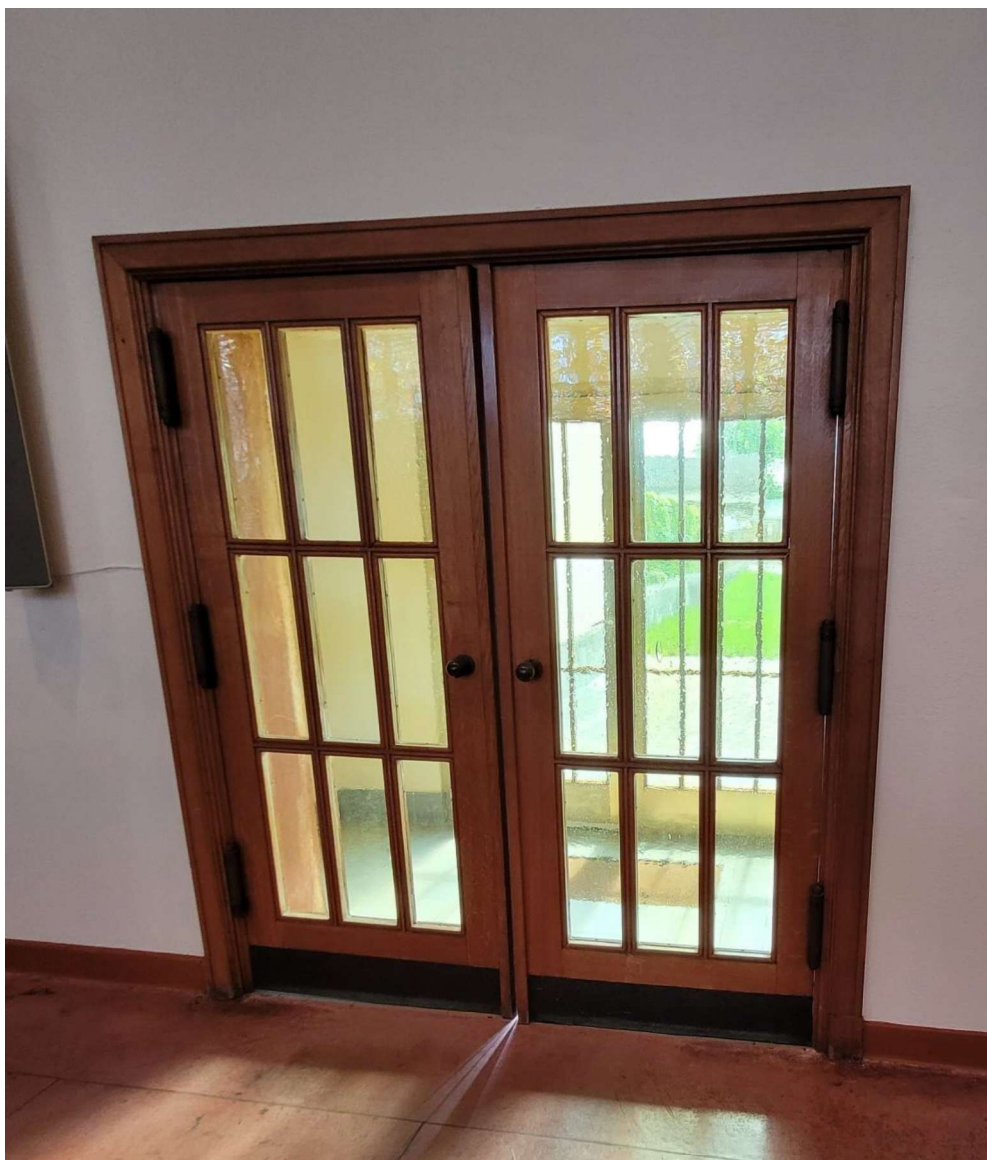
DOUBLES-PORTES DE PART ET D'AUTRE DU NARTHEX. PORTES EXTÉRIEURES EN ALUMINIUM DORÉ AVEC PETITS-'FERS', INTÉRIEURES À PETITS-BOIS, EN CHÊNE, BATTANTS PROTÉGÉS AU BAS PAR UNE LAME DE CUIVRE BOSSELÉ ; VERRES IMPRIMÉS COULEUR JAUNE. PHOTO : AWaP, DZC, AFP
