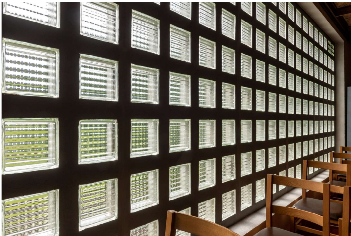
MUR EXTÉRIEUR DE LA CHAPELLE DE SEMAINE : RÉSILLE DE BÉTON ET DALLES DE VERRE POUR LE MUR-RIDEAU. PHOTO : AWAP, DST, VINCENT ROCHER (2023)
